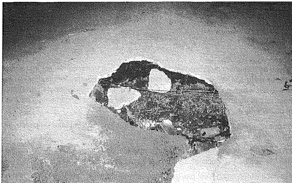
Soulèvement et éclatement d'un dallage sous l'effet d'une sous-pression. © J. Putatti
