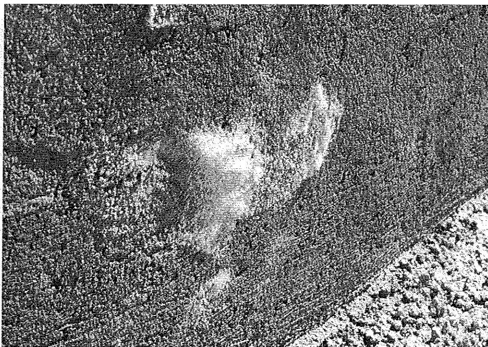
Efflorescences sur un mur de soutènement. Détail. © J. Putatti
