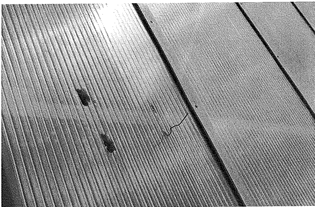
Photo 12 : Plaque polycarbonate percée dans une couverture shed soumise à une très forte tem- pête. © J. Putatti
