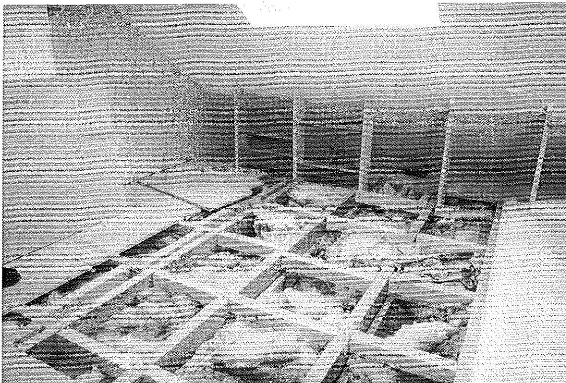
Photo 2 : Vue intérieure du comble après modification des fermettes. Les contrefiches verticales « remplacent » les contrefiches obliques supprimées. © J. Putatti
