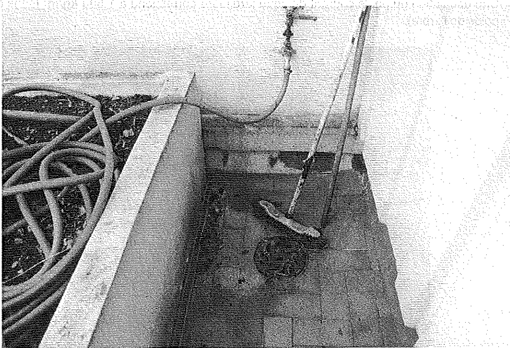
Photo 3 : Point d'évacuation des eaux pluviales de la terrasse privative. © J. Putatti
