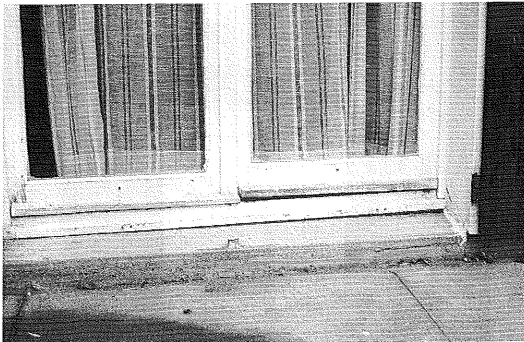
Photo 6 : Déformation bâti : traverse inférieure. © J. Putatti
