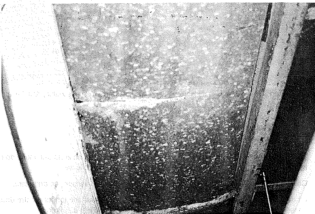
Photo 3 : Après dépose du faux-plafond, sous-face apparente du chéneau. Fuite au droit d'une liaison. Noter la présence d'un isolant (laine minérale) en sous-face du chéneau pour éviter les condensations. © J. Putatti
