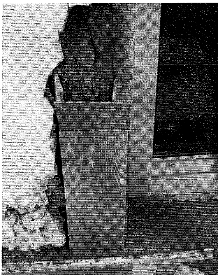
Photo 11 : Détail de reconstitution d'un poteau de pan de bois. © J. Putatti
