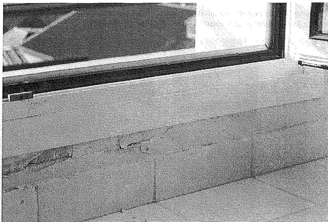
Photo 4 : Défaut d'étanchéité du seuil de la porte-fenêtre. Fuites, écaillage de la peinture. © J. Putatti
