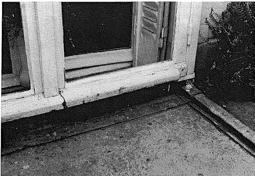
Photo 6 : Autre cas de porte-fenêtre. Relevé de la feuille de plomb. Néanmoins traverse basse extérieure altérée par l'humidité. © J. Putatti
