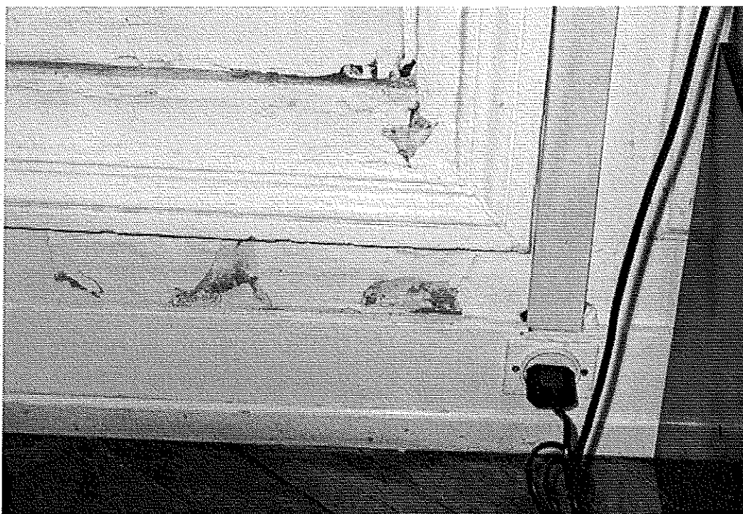
Photo 10 : Seuil de porte-fenêtre côté intérieur. Taches de couleur brunâtre correspondant à des pénétrations d'eau. Décollements de peinture. Présence d'une saignée pour mise en place d'une prise électrique nécessitant une saignée. © J. Putatti
