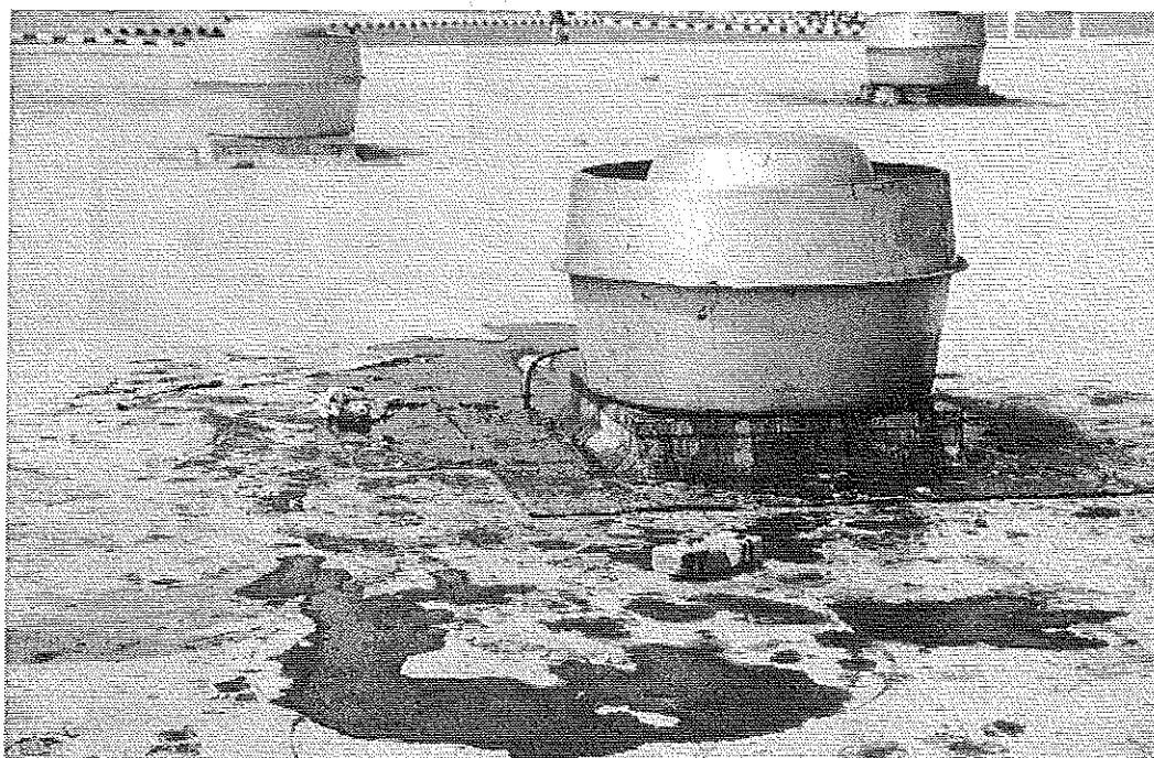
Photo 5 : Toiture industrielle plate (Égypte, côté Mer Rouge). Étanchéité par membrane synthétique. Attaques par hydrocarbures après démontage d'un extracteur. © J. Putatti
