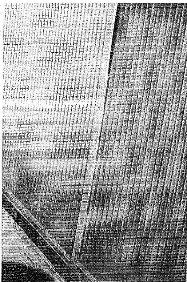
Photo 10 : Face nord d'une couverture shed. Déformation des lisses support. © J. Putatti
