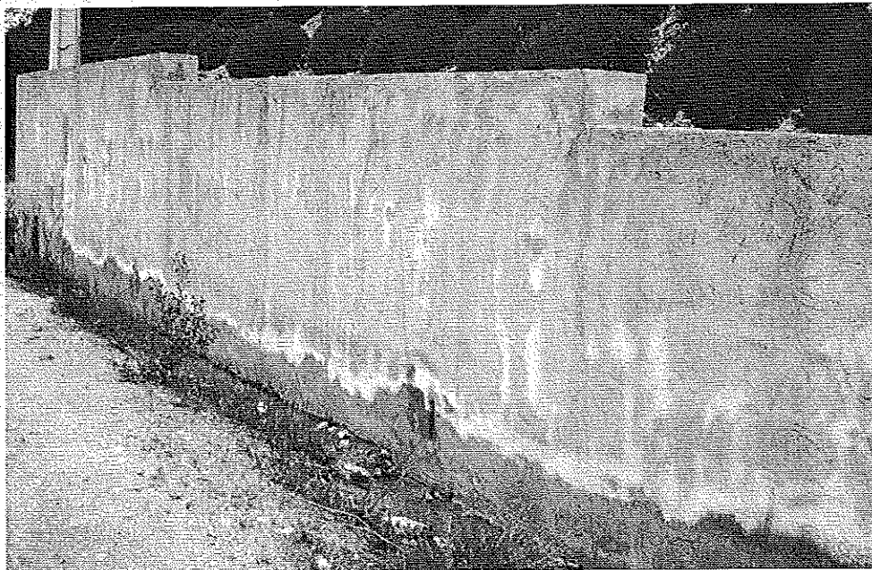
Autre mur affecté par les phénomènes d'efflorescences avec influence des remontées capillaires. © J. Putatti
