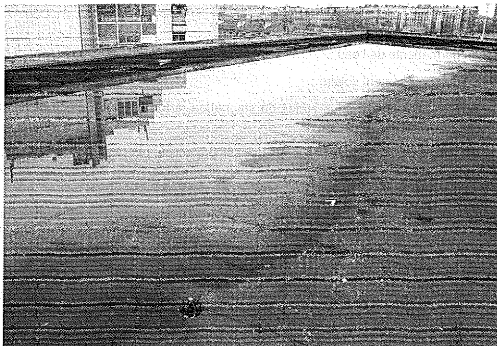
Terrasse plate noyée en permanence sur une grande partie de sa surface. © J. Putatti
