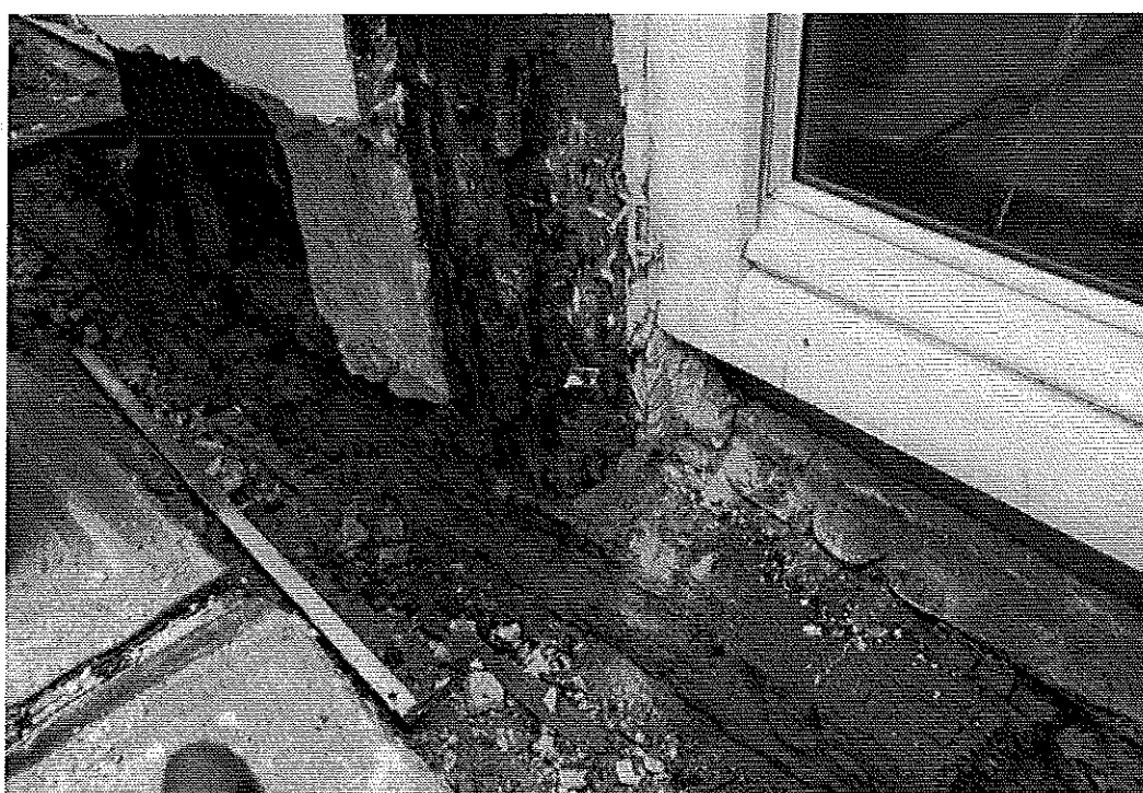
Photo 2 : Détail poteau de pan de bois en limite d'un trumeau. Destruction avancée de la base du poteau et de la longrine filante. © J. Putatti
