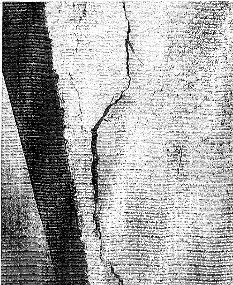
Photo 4 : Détail fissure verticale entre mur local et mur en retour.
