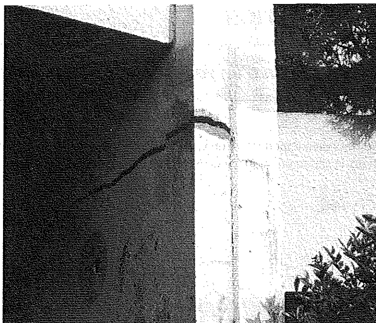
Photo 2 : Détail fissure (ouverture > 25 mm). Noter la présence d'un joint de structure. © J. Putatti
