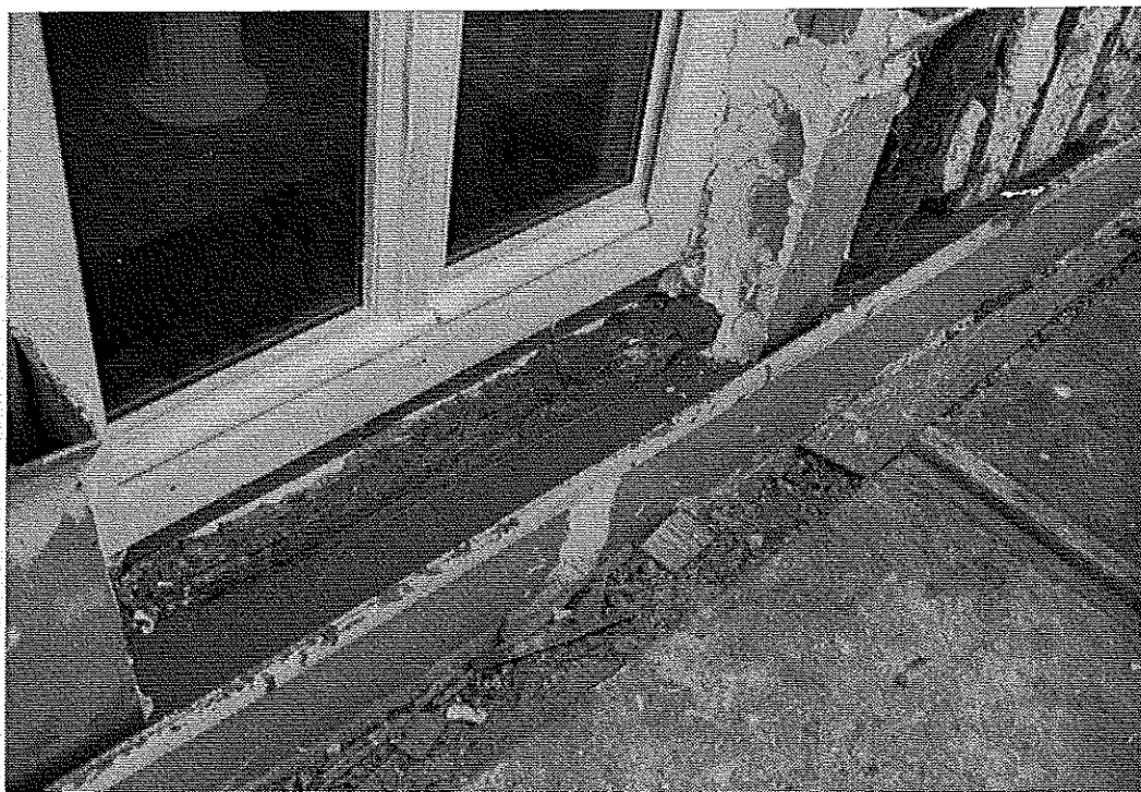
Photo 10 : Reconstitution de la longrine basse par coulage d'un mortier de résine entre coffrage. Reconstitution des poteaux du pan de bois (partie inférieure) par mortier de résine coffré. © J. Putatti
