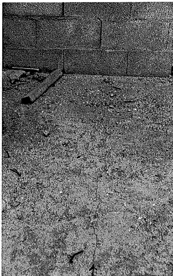
Photo 8 : Fissuration de la dalle de compression du plancher à l'extrémité de la zone console ↑. © J. Putatti
