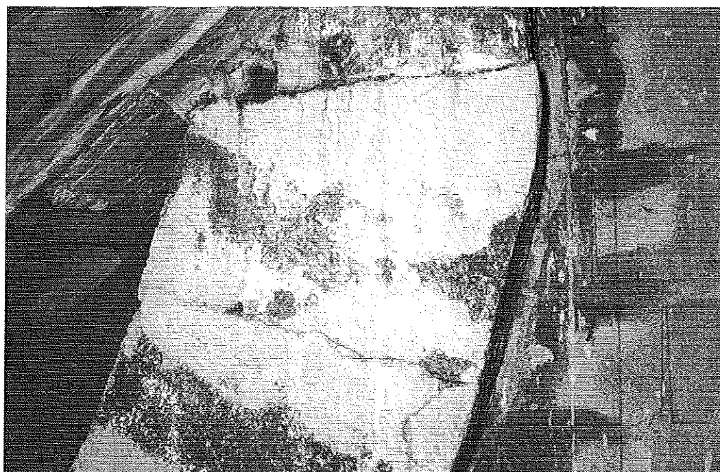
Photo 5 : Détail du conduit dévié. Fissuration des joints, infiltrations latérales dans le mur pignon. © J. Putatti
