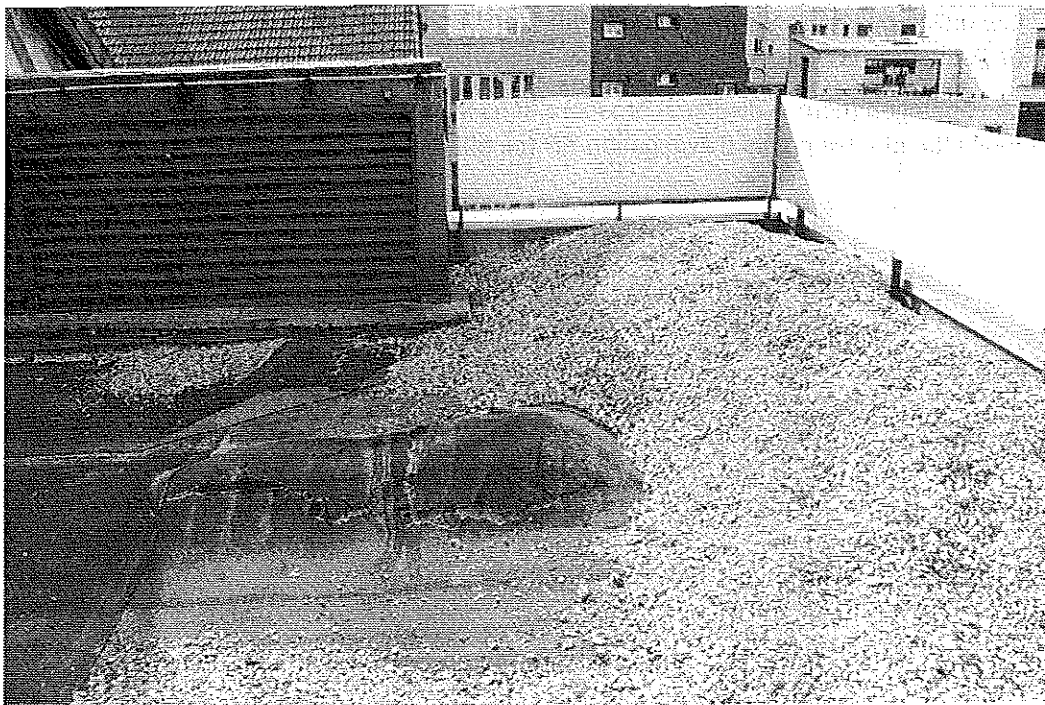
Photo 6 : Formation d'une cloque très importante après dépose des chemins de dalle et du gravillon de protection meuble. © J. Putatti
