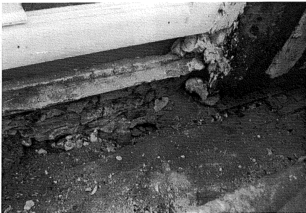
Photo 3 : Détail zone correspondant à la destruction totale de la poutre-longrine. Trace de l'ancien seuil. Base du nouveau bâti de porte-fenêtre. © J. Putatti
