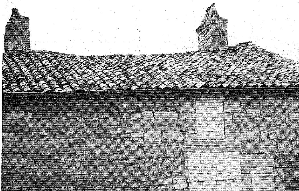
Photo 4 : Couvertures en tuiles canal. Affaissement du faîtage et déformation. © J. Putatti
