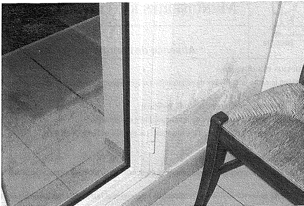
Photo 2 : Remontées d'humidité dans les murs latéraux. Insuffisance de seuil. © J. Putatti
