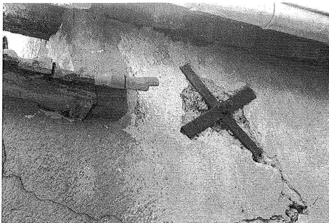
Photo 3 : Maçonnerie porteuse en pisé. Fissurations-décollement d'enduit. Mise en place d'un chaînage métallique bloqué par une croix de Saint-André. © J. Putatti
