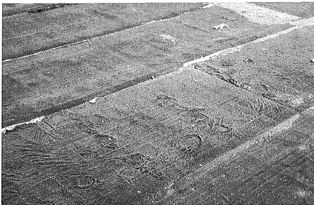
Photo 1 : Marques de pose sur revêtement d'étanchéité. © J. Putatti
