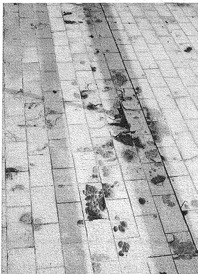
Photo 1 : Éclatement des carreaux en écailles. © J. Putatti
