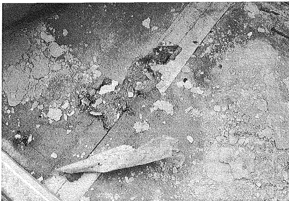
Après dépose de la feuille détruite par corrosion, découverte du support (panneau de particules) et accumulation d'oxyde de zinc. Présence d'une bande de pontage du joint entre panneaux. © J. Putatti
