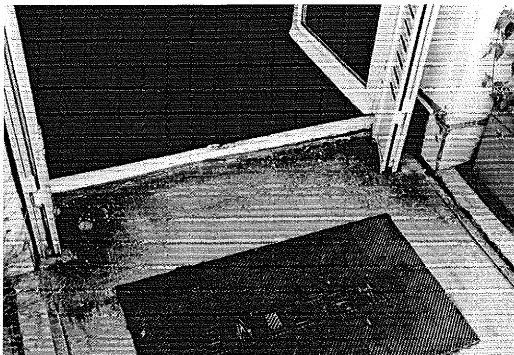
Photo 7 : Cas de porte-fenêtre présentant un seuil de hauteur insuffisante sans rejjingot. © J. Putatti
