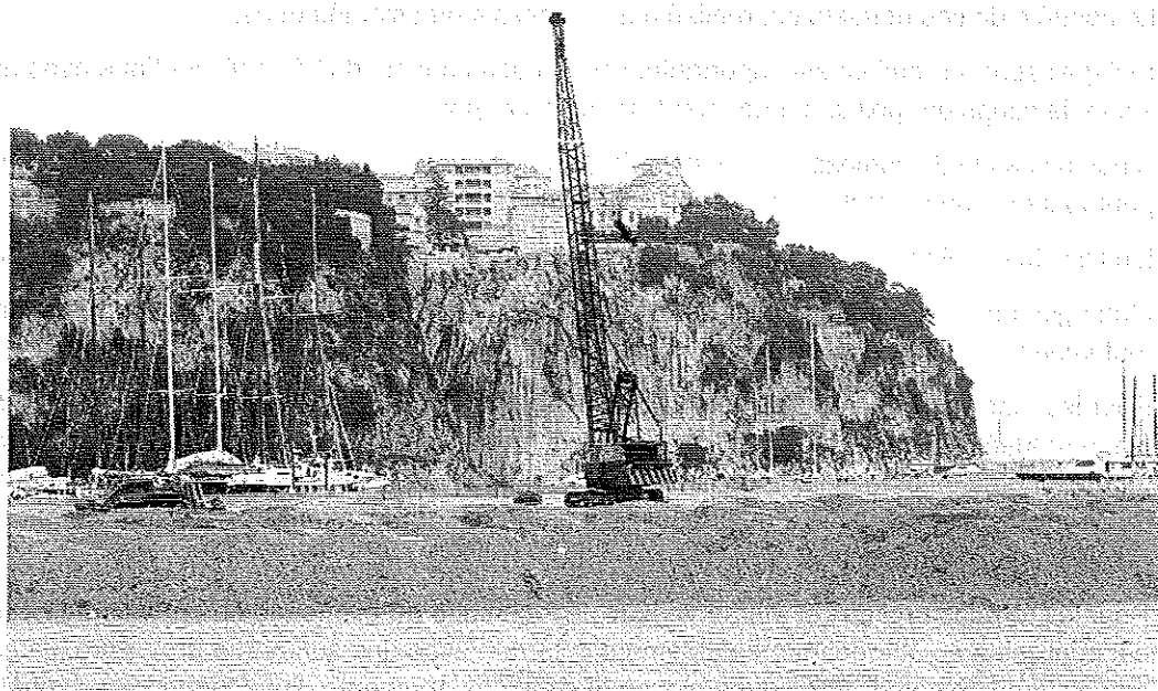
Photo 1 : Compactage dynamique, extension du port de Monaco. Engin de compactage. © J. Putatti
