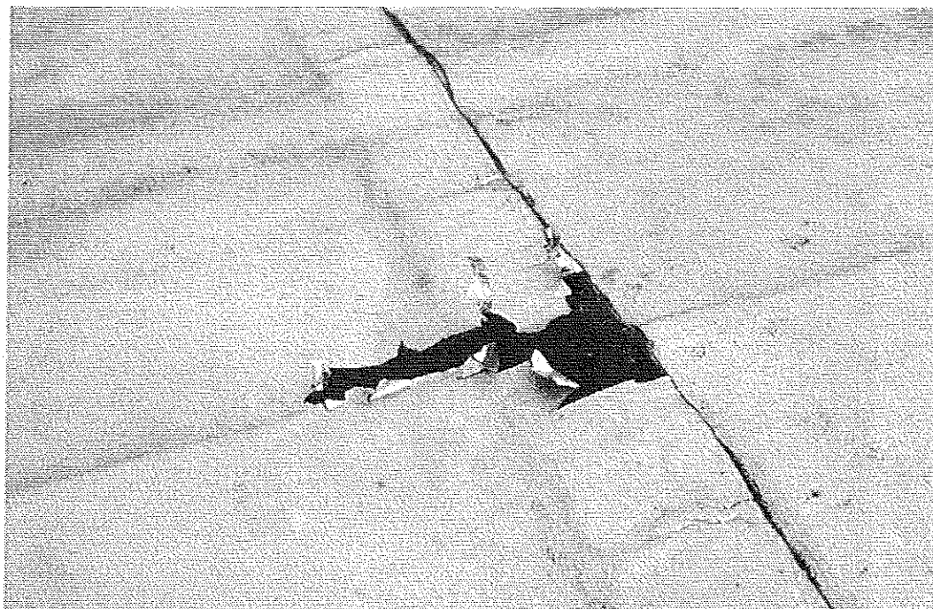
Photo 4 : Arrachement de l'autoprotection métallique provoqué par les oiseaux marins (toiture en Suède), au droit d'un pli et d'une lisière de feuille. © J. Putatti
