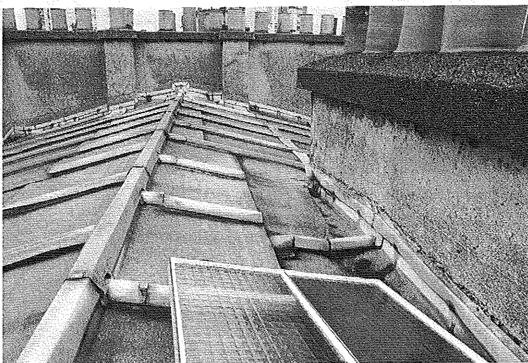
Photo 8 : Versant opposé sur cour avec souche importante (mitoyen nord). Noter le dispositif d'évacuation des EP à l'arrière de la souche. © J. Putatti
