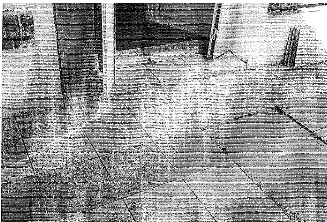
Photo 5 : Seuil de hauteur insuffisante. Origine probable de la fuite à travers le plancher. © J. Putatti
