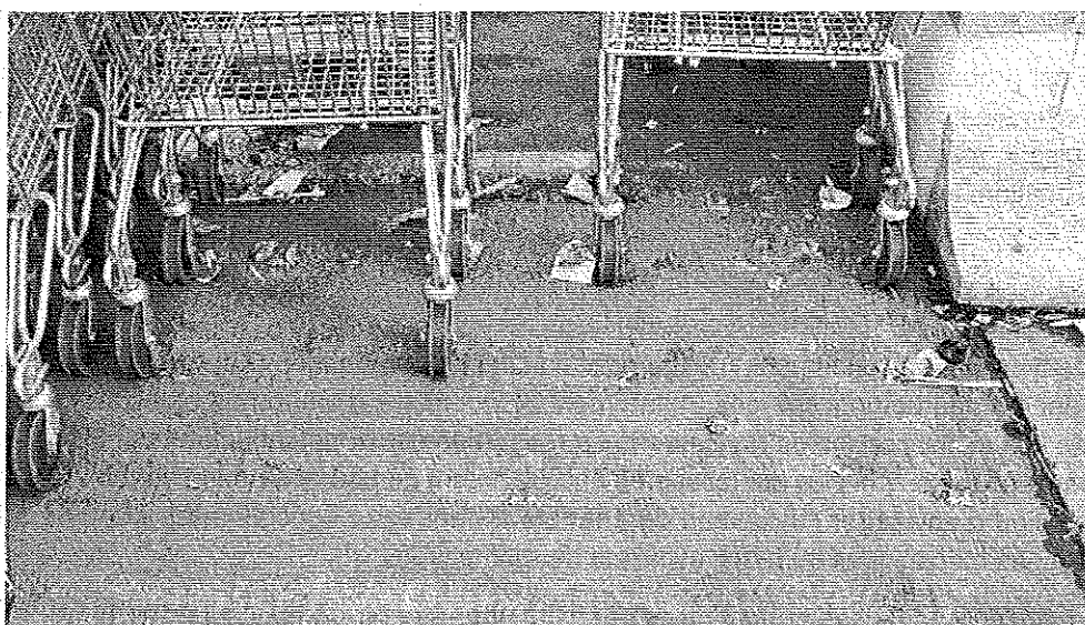
Zone de « garage » des chariots (caddies). Indentation (empreintes) des roues dans le revêtement de protection. © J. Putatti
