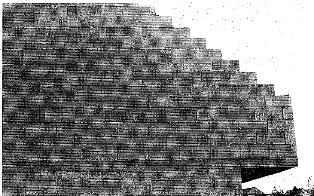
Photo 4 : Fissuration au droit des joints de hourdage des blocs béton dans une zone en débord d'un pignon. © J. Putatti
