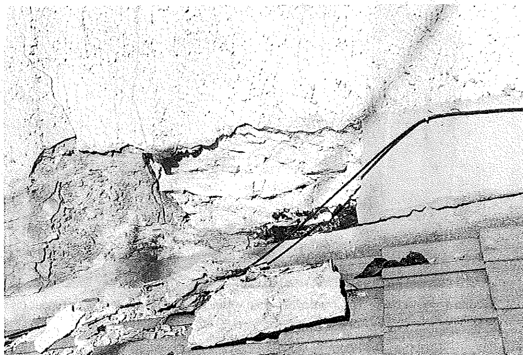
Photo 6 : Détail solin (zone éclatée). Le mur mitoyen en moellons apparaît. © J. Putatti
