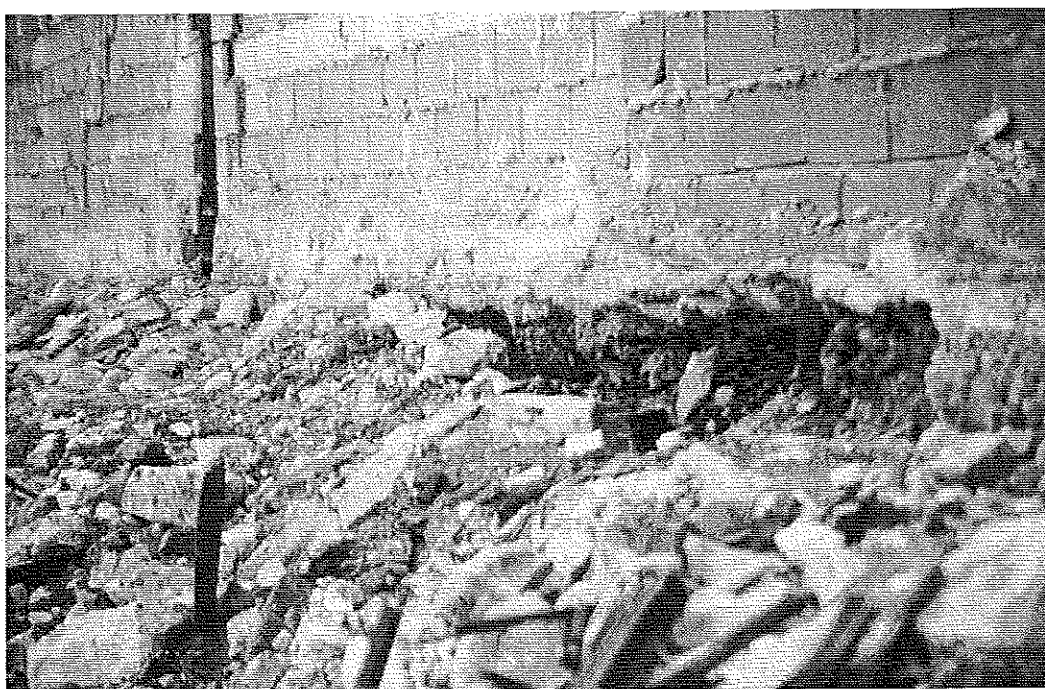
Photo 3 : Bâtiment en limite. Zone comportant une fondation (sommaire) de mur affouillée par les terrassements généraux. © J. Putatti
