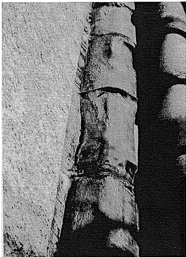
Photo 4 : Détail de la feuille de plomb déformée au droit des recouvrements de tuile. © J. Putatti
