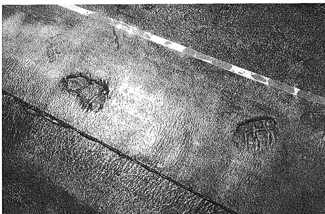
Photo 2 : Marque de pas sur un revêtement bicouche (1 re couche) posé par période chaude. © J. Putatti
