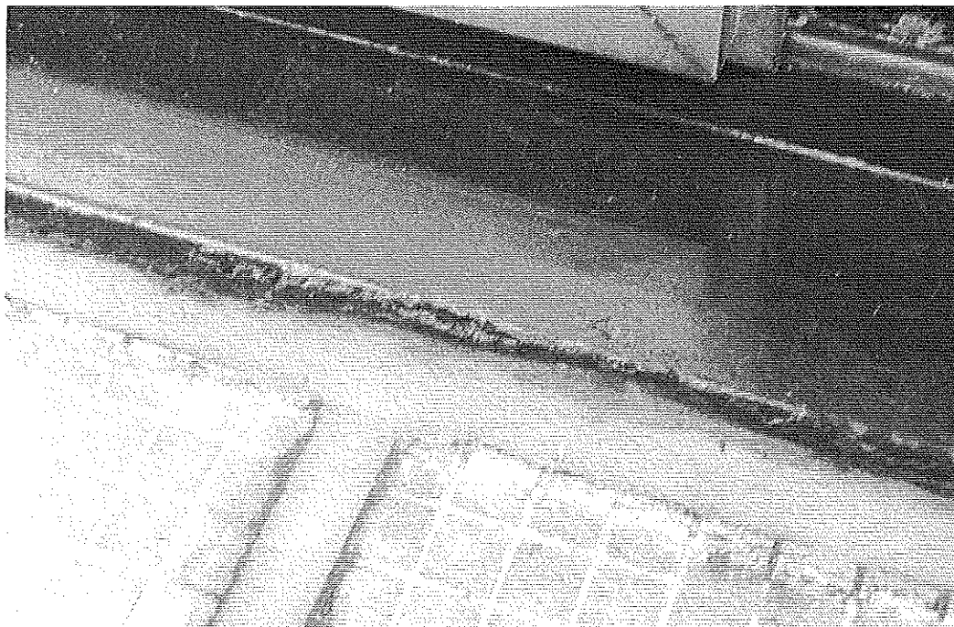
Photo 10 : Réparation partielle d'un joint de mastic au droit d'un seuil - Corrosion de la menuiserie (terrasse 6 e étage). © J. Putatti
