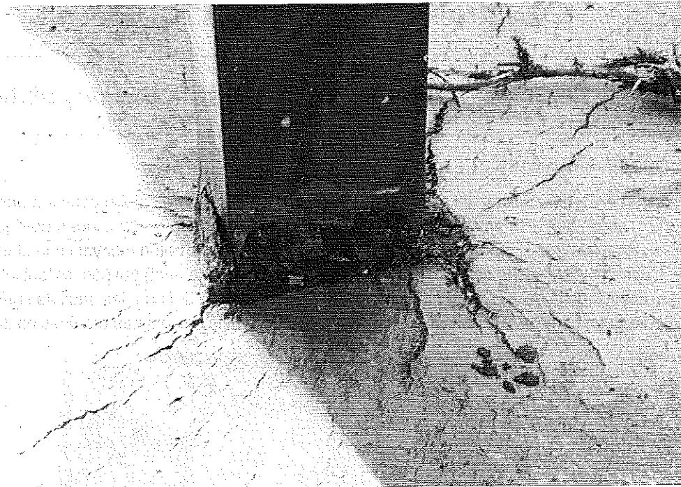
Détail de pied de poteau en cours de destruction par corrosion. © J. Putatti
