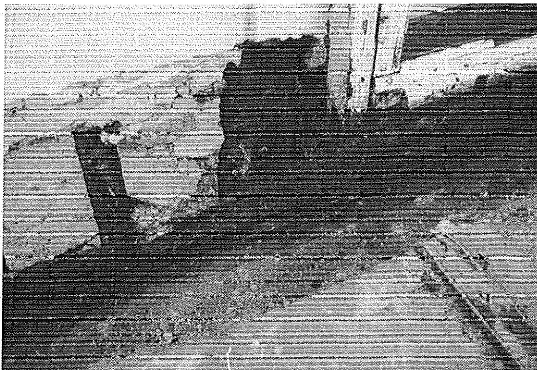
Photo 13 : Dégagement de la base du pan de bois. Altérations importantes de la structure bois. © J. Putatti
