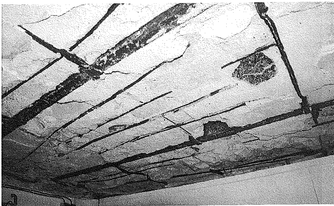
Photo 5 : Plancher de cave sous pièce humide (cuisine). Poutrelles métalliques et remplissage hourdis de plâtre armé avec suspentes métalliques. Corrosion avancée. © J. Putatti
