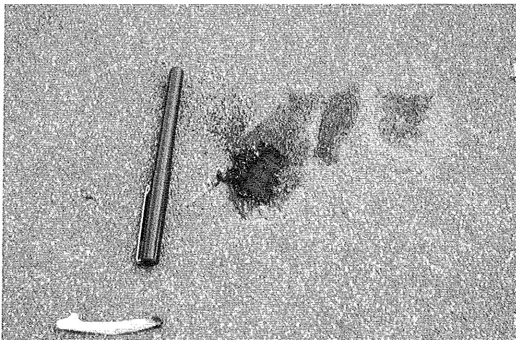
Photo 4 : Autre type plus étalé. Une partie correspond à une attaque profonde (échelle : stylo = 0,14 m). Un os d'oiseau a été trouvé à proximité du désordre. © J. Putatti
