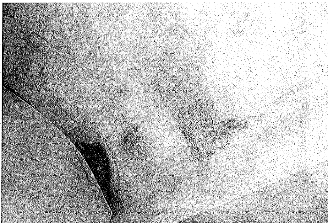
Photo 1 : Taches d'infiltration et de condensation (pièce humide), moisissures. © J. Putatti
