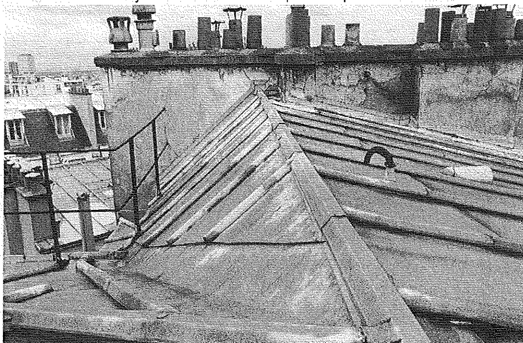
Photo 3 : Pignon contre mitoyen sud. Raccord faîtage deux versants cour/rue et arêtier côté cour. © J. Putatti
