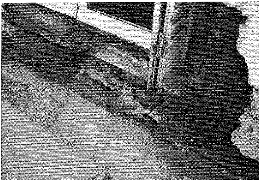
Photo 15 : Zone particulière correspondant à la disparition partielle de la longrine basse. © J. Putatti
