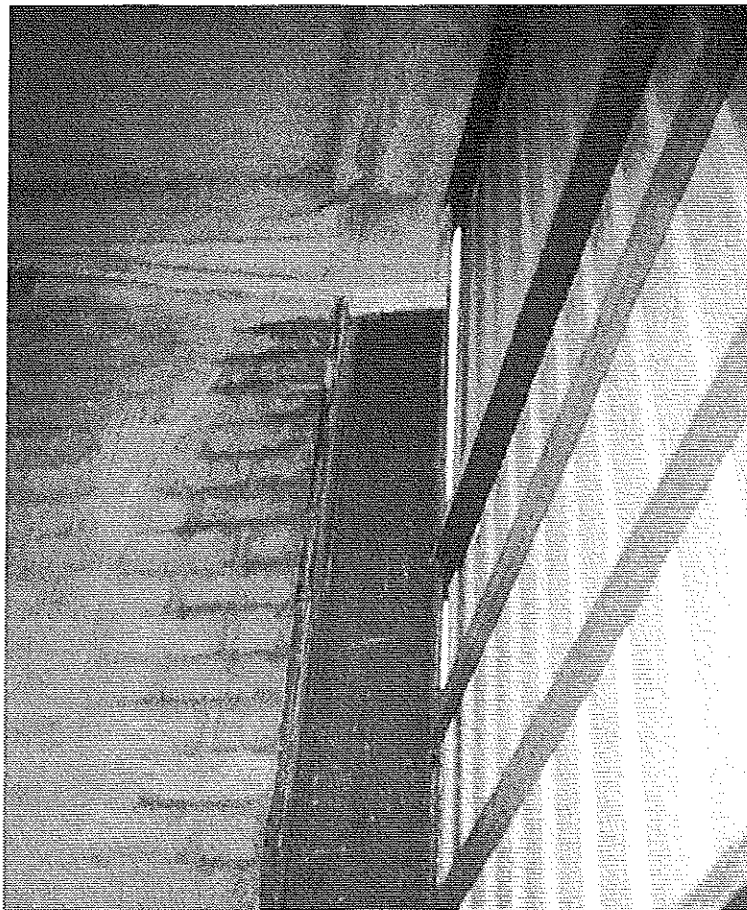
Photo 2 : About de la rive biaise. Fuite au droit du poteau de rive. © J. Putatti
