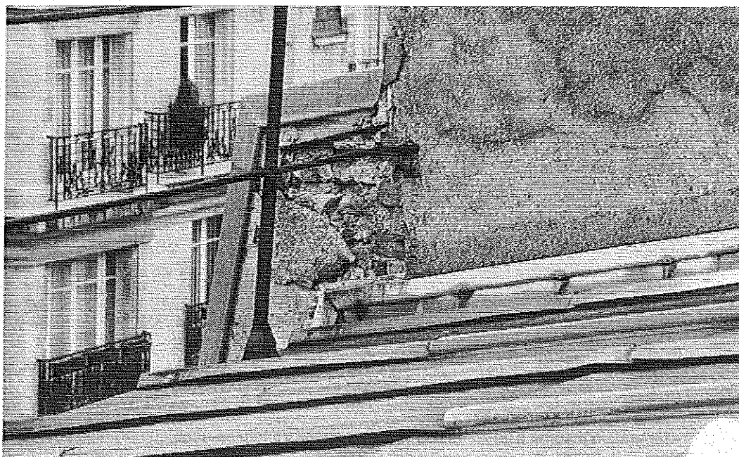
Photo 10 : Détail versant sur rue, partie basse. Raccord avec mitoyen. Mur en très mauvais état, absence d'enduit (défaut d'étanchéité), trace de rouille en provenance du garde-corps en rive basse.
