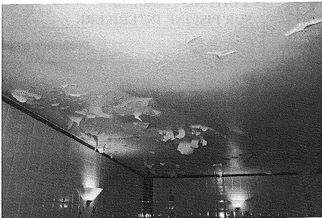
Photo 2 : Altération du plafond (peinture sur plaques en plâtre cartonné). Accentuation des joints de plaque. © J. Putatti
