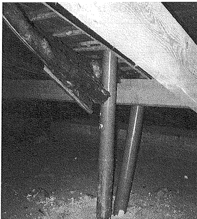
Photo 3 : Bande de laine isolante détachée. Noter les dépôts de poussières et moisissures. © J. Putatti
