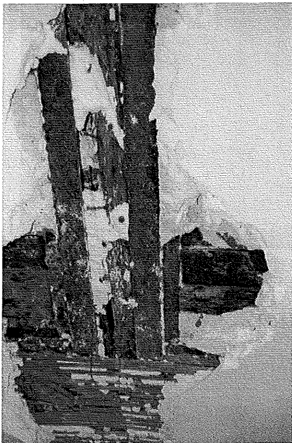
Photo 11 : Sondage pratiqué au droit d'un trumeau porteur de l'étage sous-jacent dans le plancher. Présence de poutrelles métalliques au droit d'une ancienne poutre bois. © J. Putatti
