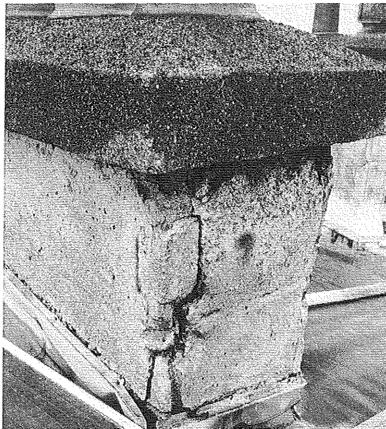
Photo 13 : Détail souche sur versant cour. Maçonnerie en très mauvais état. Solin à reprendre. © J. Putattii
