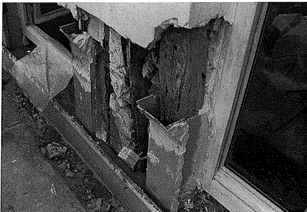
Photo 12 : Reconstitution d'un trumeau porteur d'étage. Utilisation de coffrages pour coulage du mortier de résine. © J. Putatti
