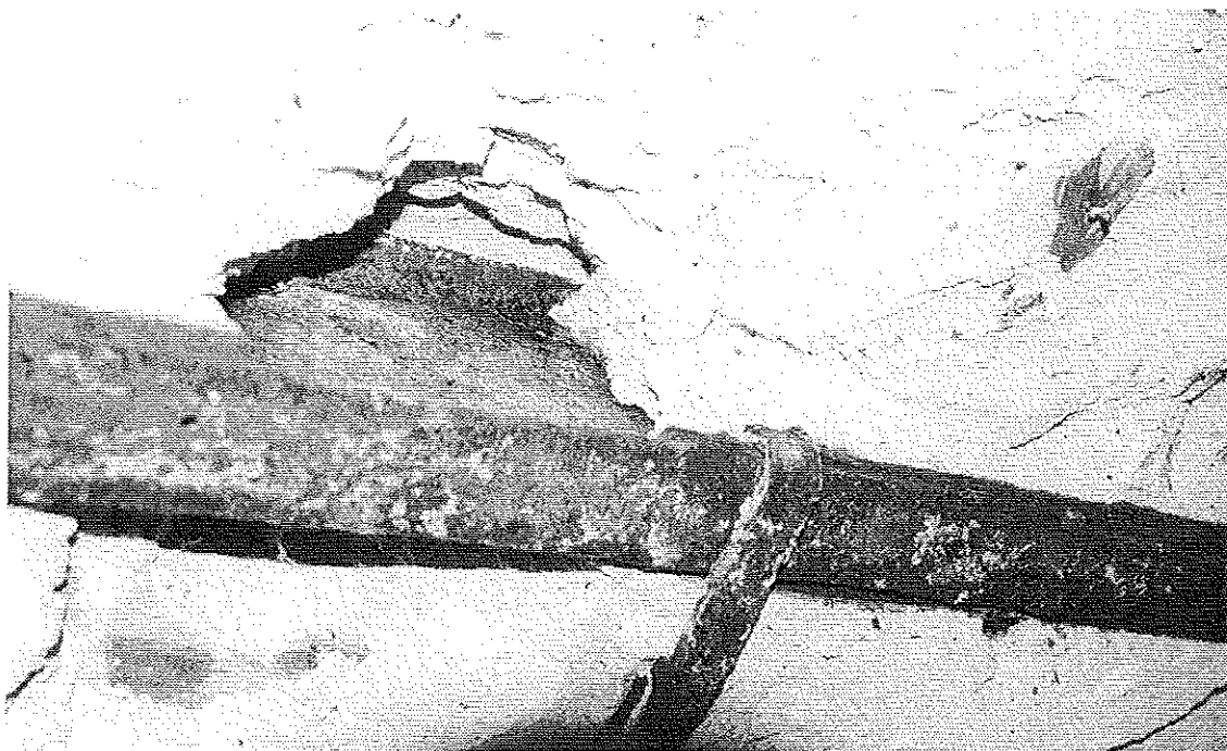
Photo 7 : Détail poutrelle après sondage. Corrosion avancée. © J. Putatti
