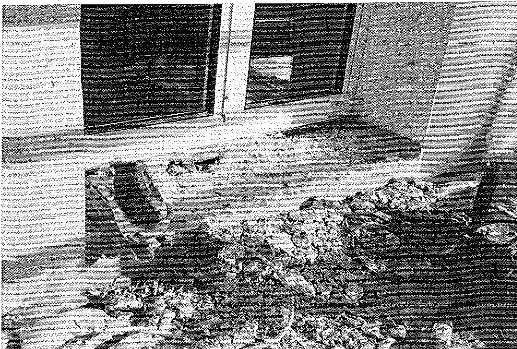
Photo 6 : Porte-fenêtre. Repiochage du seuil pour abaisser le niveau et « tenter » de réaliser « après-coup » un rejingot. © J. Putatti
