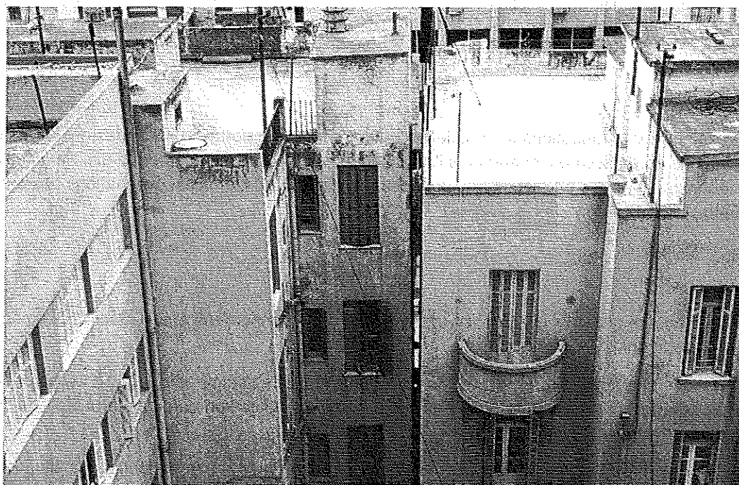
Photo 1 : Tassements différentiels entre deux immeubles (Tunis). L'immeuble de gauche a subi une rotation d'ensemble. © J. Putatti
