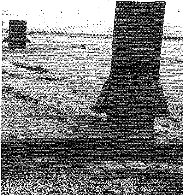
Photo 1 : Toiture industrielle en France. Revêtement sur support en dalles de béton cellulaire. Sorties d'extracteurs. © J. Putatti
