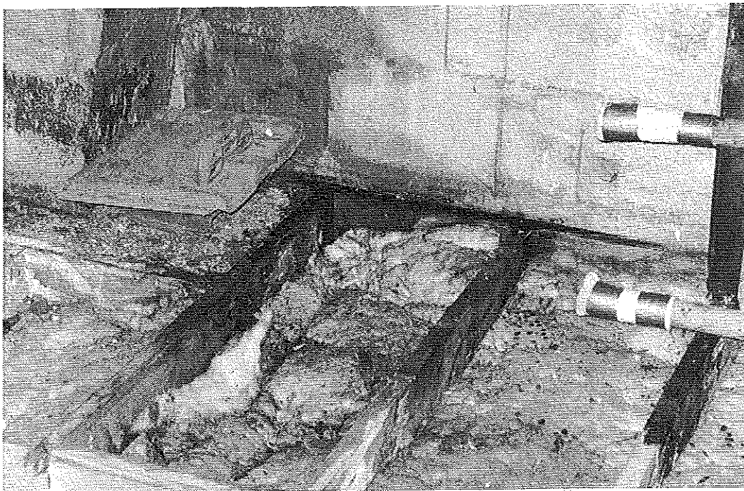
Photo 6 : Zone du plancher du comble près du conduit. Poutrelles bois saturées d'eau ainsi que l'isolant laine minérale. Attaque des bois. © J. Putatti
