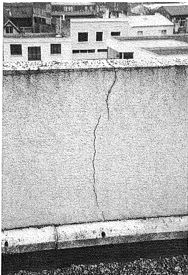
Photo 1 : Fissuration verticale de l'acrotère (zone en dehors des joints de fractionnement). Fissure de décollement de l'enduit de dessus d'acrotère. © J. Putatti
