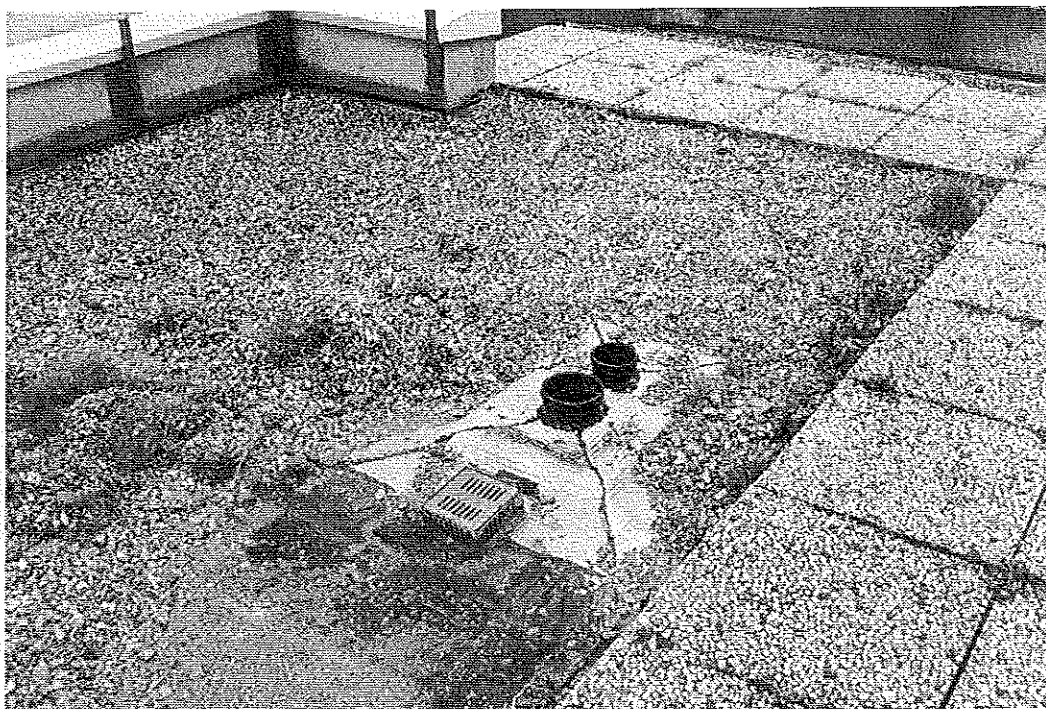
Photo 3 : Zone d'accès. Début de cheminement par dalle. Dispositif d'évacuation EP. © J. Putatti
