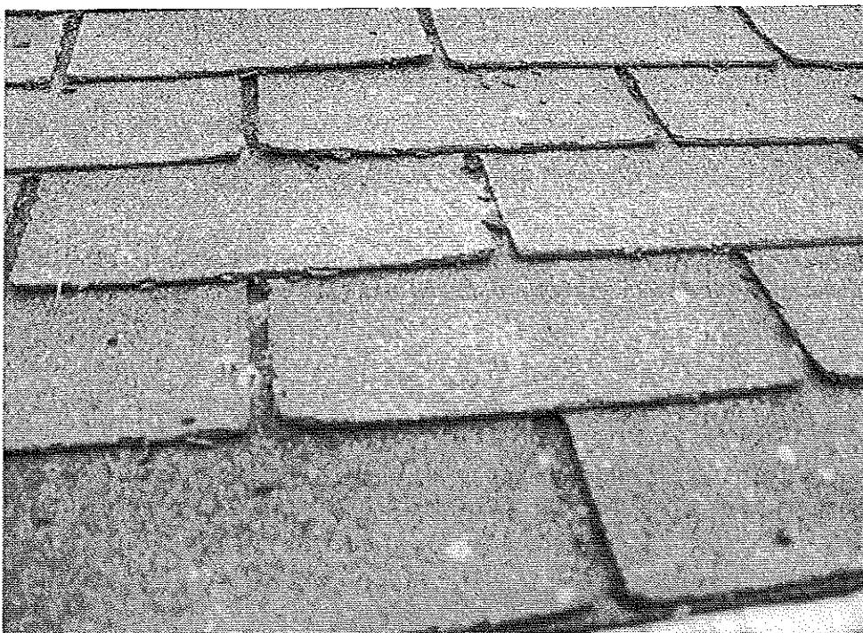
Photo 2 : Détail des bardeaux altérés. © J. Putatti
