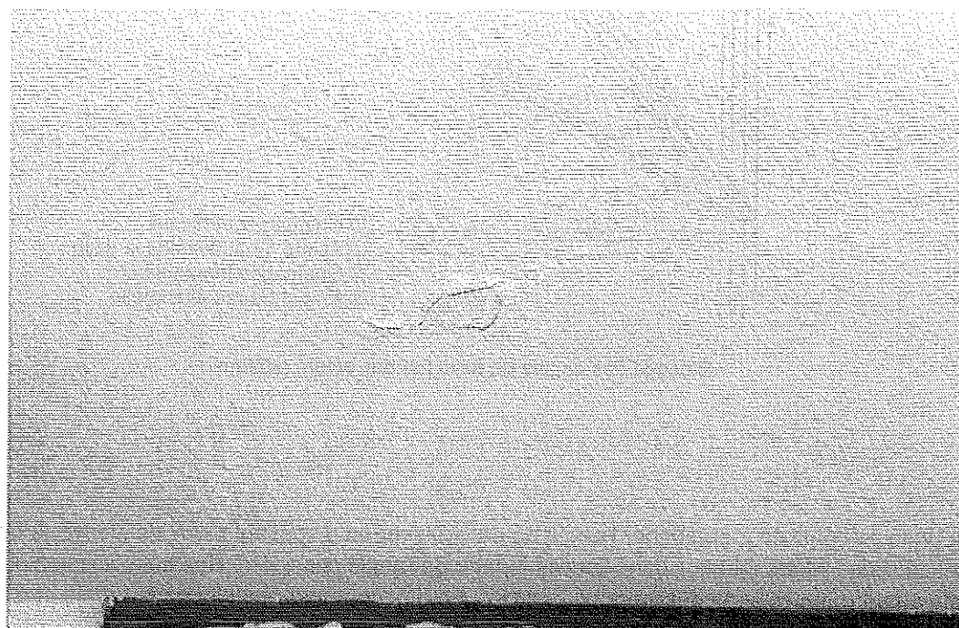
Photo 2 : Fissure d'angle à 45° dans une dalle BA sous toiture-terrasse. Fissure infiltrante, décollement et cloquage du film peinture plafond. © J. Putatti
