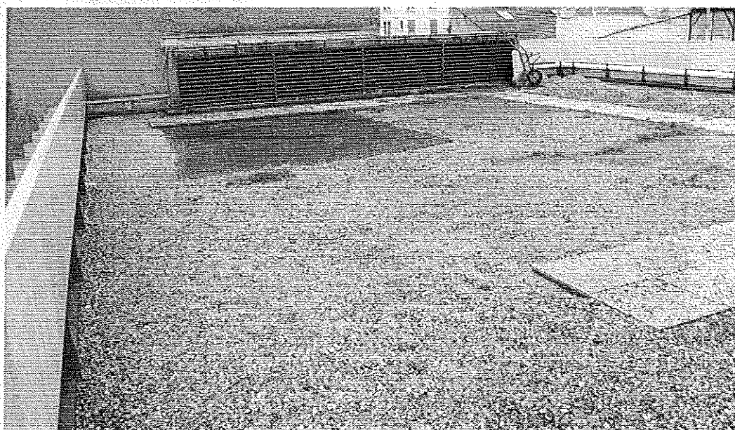
Photo 2 : Autre installation (sorties de ventilation), accès par chemin de dalle, stagnations d'eau. © J. Putatti
