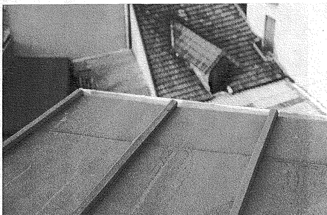
Photo 3 : Zone de recouvrement dans une rive (ou près d'une rive) d'égout. © J. Putatti
