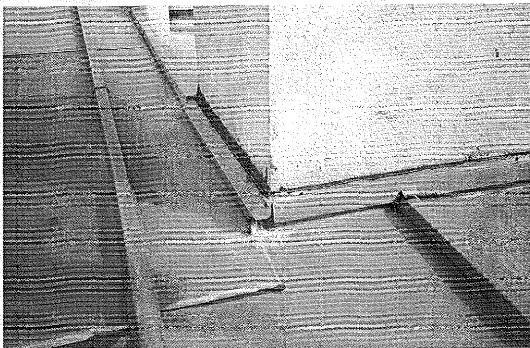
Photo 7 : Défaut de raccordement de feuilles autour d'une souche ; soudure « à plat » ; solin mal réalisé. Raccordement solin/tasseau défectueux. © J. Putatti
