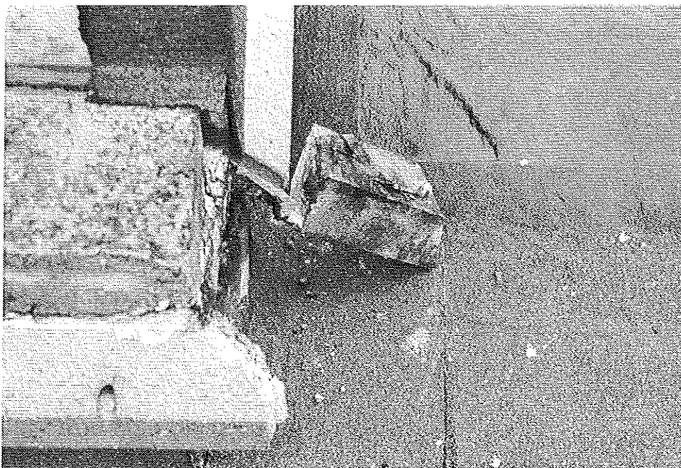
Rupture d'un élément de bandeau près d'un angle (une seule fixation mécanique). © J. Putatti
