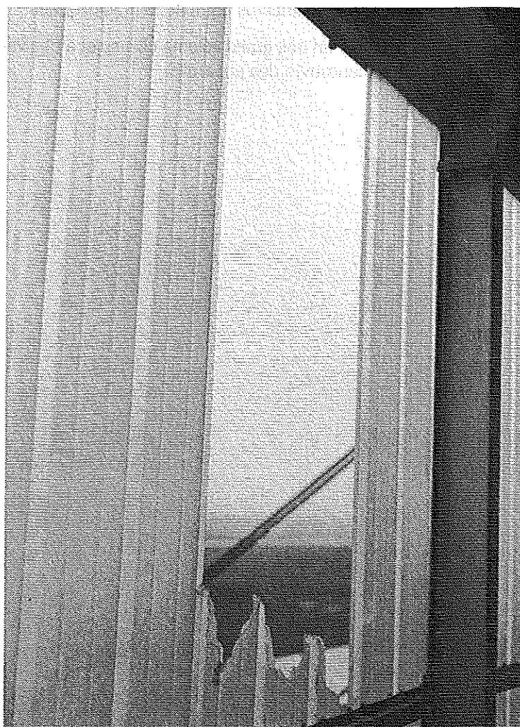
Bardage éclaté (vu de l'intérieur). © J. Putatti
