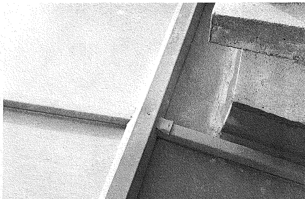
Photo 4 : Raccordement type d'un couvre-joint de faîtage avec couvre-joint de tasseau (utilisation de clous). © J. Putatti
