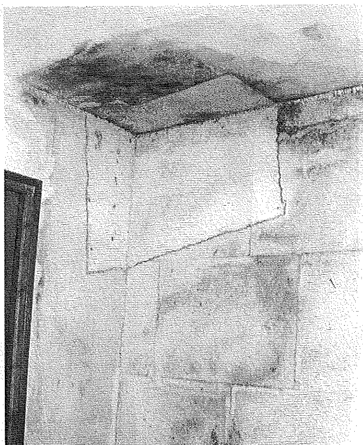
Photo 3 : Désordres dans l'autre pièce adjacente. L'humidité et les moisissures concernent l'angle du plafond et la hauteur de la cloison de doublage (carreaux de plâtre), tentures décollées. © J. Putatti
