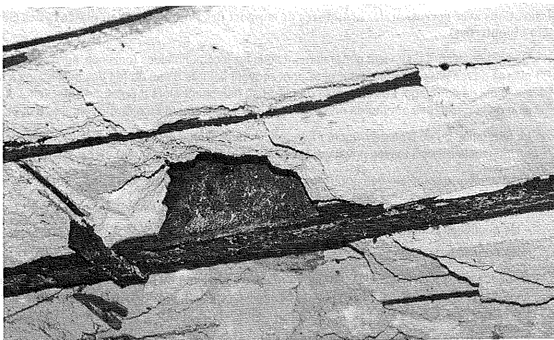
Photo 6 : Détail d'une poutrelle après sondage. La poutrelle en fer a subi une corrosion importante du fait des infiltrations à travers le carrelage de la cuisine située au-dessus. Noter les éléments de plâtre détachés du plafond. © J. Putatti
