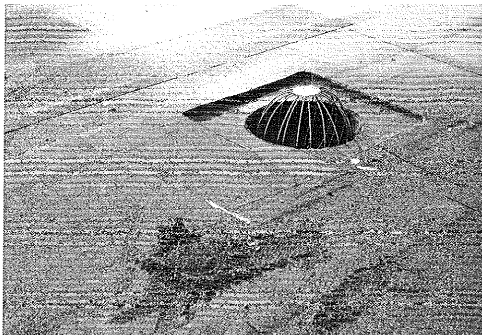
Photo 1 : Revêtement d'étanchéité autoprotégé par granulés minéraux. © J. Putatti
