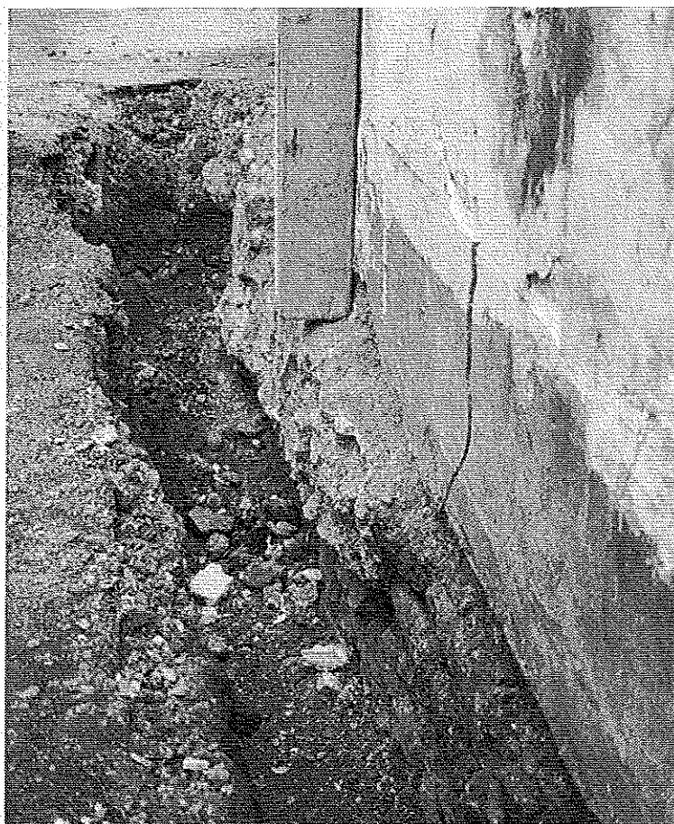
Photo 4 : Partie basse du mur (ancien mitoyen). Présence d'une fissure ouverte ( \geq 0,01 m). Dégagement des fondations du pignon et de l'angle façade. © J. Putatti
