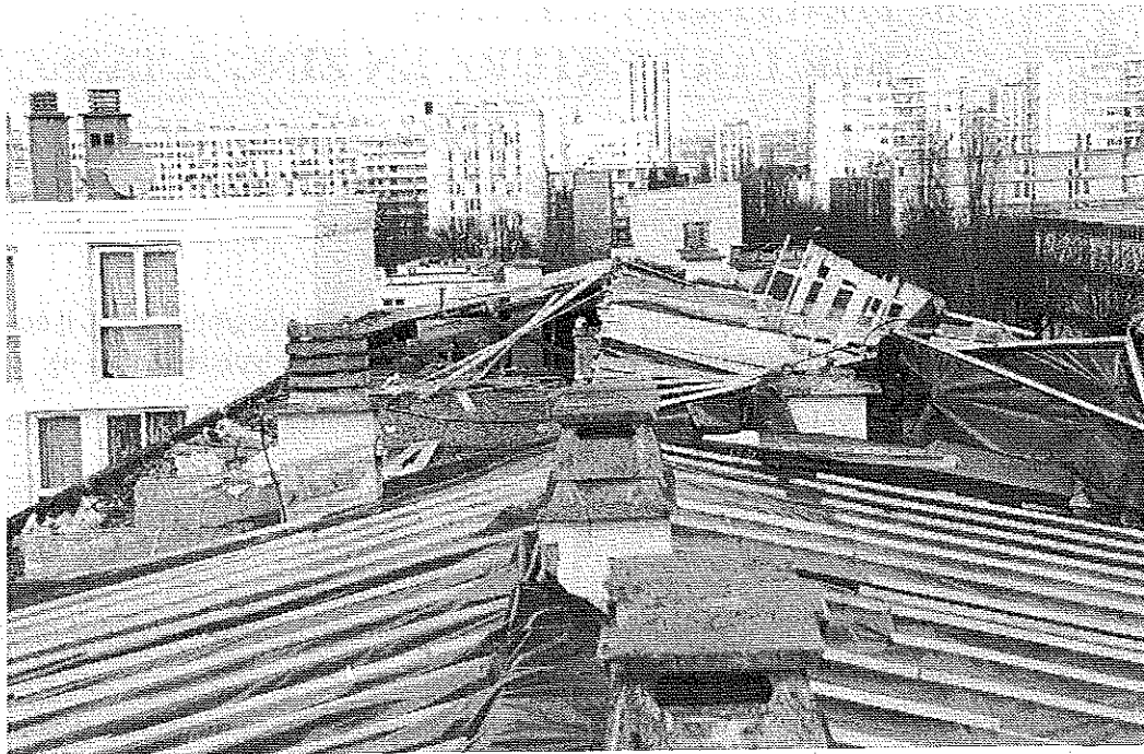
Photo 2 : Vue de la zone en cours de remise en état (2 e phase), premier plan. Au second plan, ensemble bâchage replié par la deuxième tempête. © J. Putatti
