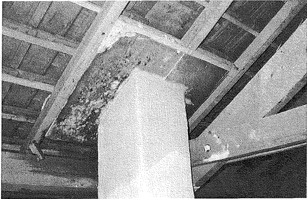
Photo 8 : Zone de souche après dépose de l'isolant en sous-face. Traces de moisissures et dépôts de calcite. Bois de charpente humidifié. © J. Putatti
