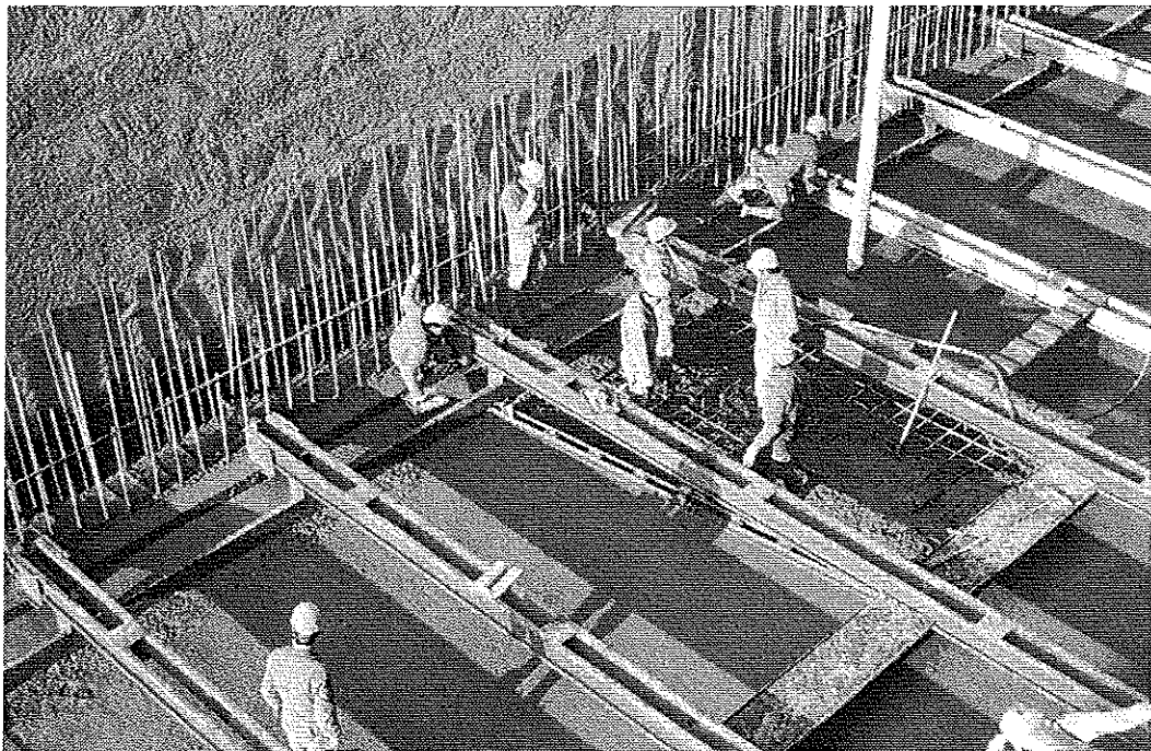
Photo 4 : Exécution de l'ouvrage définitif (radier). Noter les aciers en attente pour les voiles verticaux du tunnel. © J. Putatti
