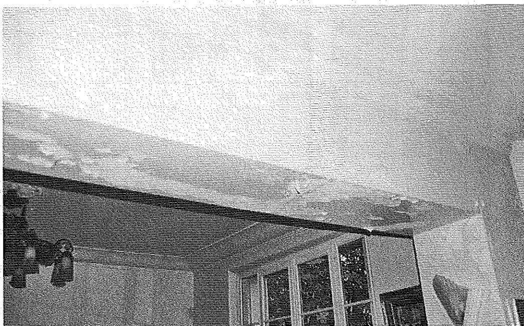
Photo 7 : Aspect de la poutre de reprise des maçonneries de l'étage, après infiltrations sur plusieurs mois (seuil photo 5 situé au-dessus). © J. Putatti
