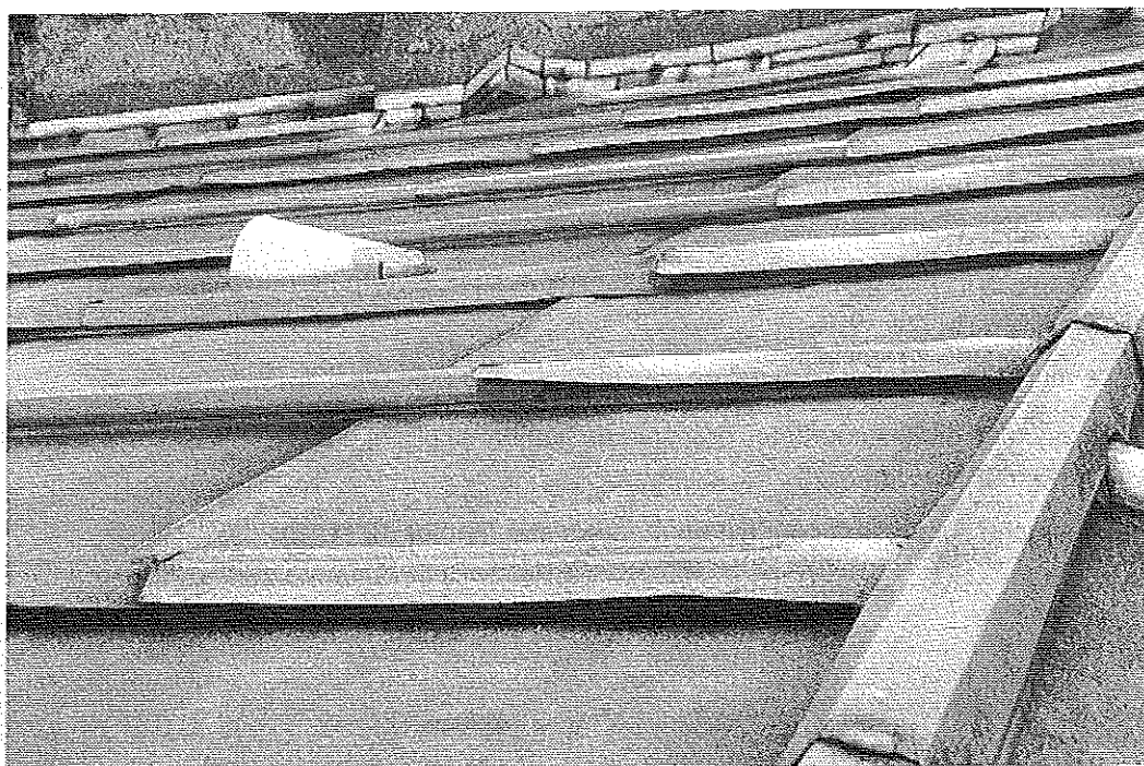
Photo 7 : Détail versant sur rue. Noter le soulèvement des couvre-joints de tasseaux (étanchéité ?) courants et ceux du faîtage et leur raccordement. © J. Putatti
