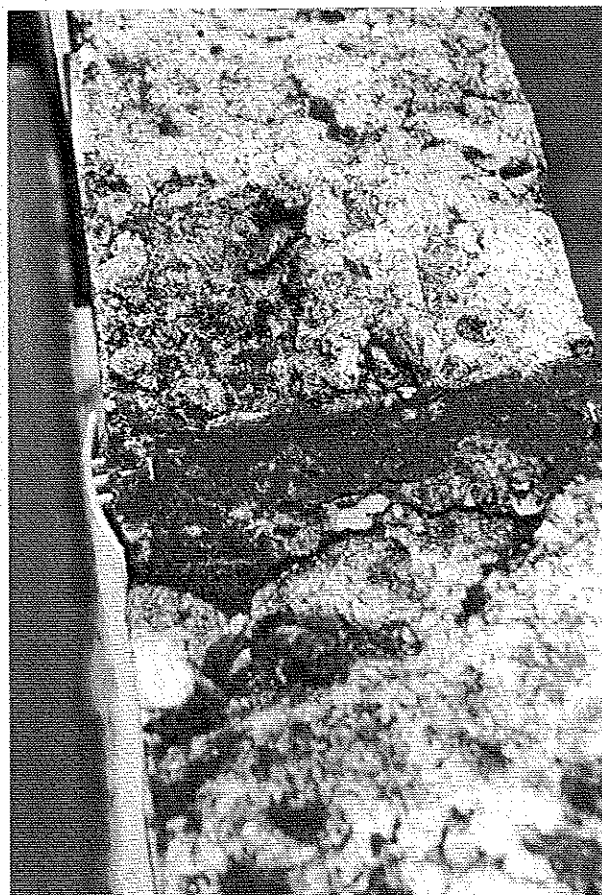
Photo 3 : Détail dessus d'acrotère ; enduit de couronnement décollé, armatures acrotère apparentes. © J. Putatti
