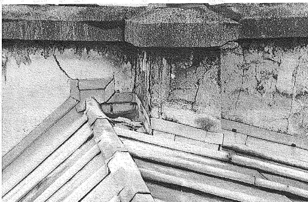
Photo 5 : Détail pignon contre mitoyen sud. Présence d'une souche et d'une zone arrière de souche sans besace. © J. Putatti
