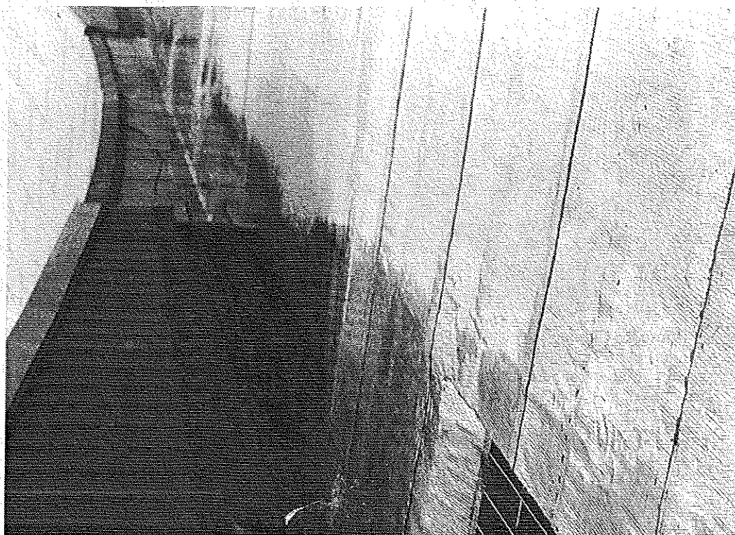
Photo 1 : Chêneau central du hangar (vue partielle). L'eau est collectée par les voûtes concaves (zone sans retombée) et tombe de plus de 1 m sur le revêtement d'étanchéité autoprotégé par feuille d'aluminium (bitume armé 40) pour s'évacuer par des avaloirs. © J. Putatti
