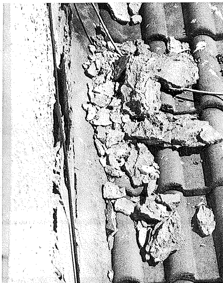
Photo 5 : Détail solin vu par-dessus. Éclatement du solin. © J. Putatti
