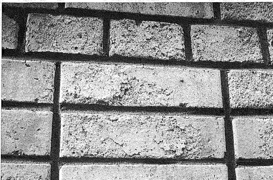
Photo 1 : Phénomène de gel sur une maçonnerie de briques pleines. © J. Putatti
