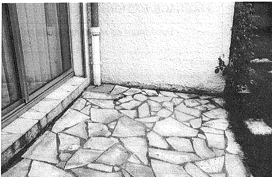
Photo 1 : Dallage extérieur sur terre-plein. Tassement d'ensemble. Décollement des murs périmétriques. © J. Putatti
