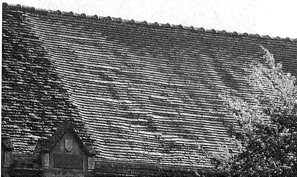
Photo 1 : Couverture en tuiles plates en Bourgogne (pente 100 % environ). Déformations locales avec glissement des tuiles. © J. Putatti
