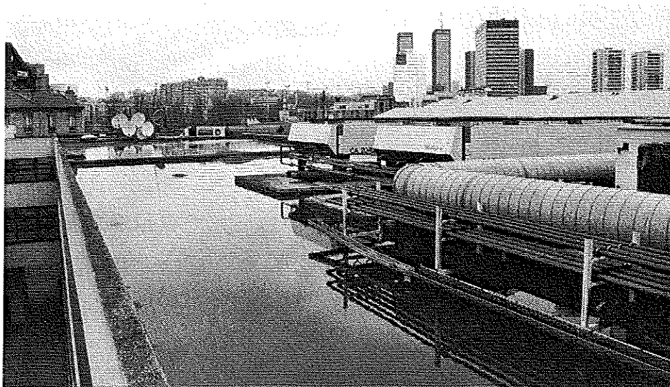
Photo 2 : Mêmes remarques que photo 1. L'eau stagne. Il n'y a pas de chemin de dalle pour accès aux installations techniques. © J. Putatti
