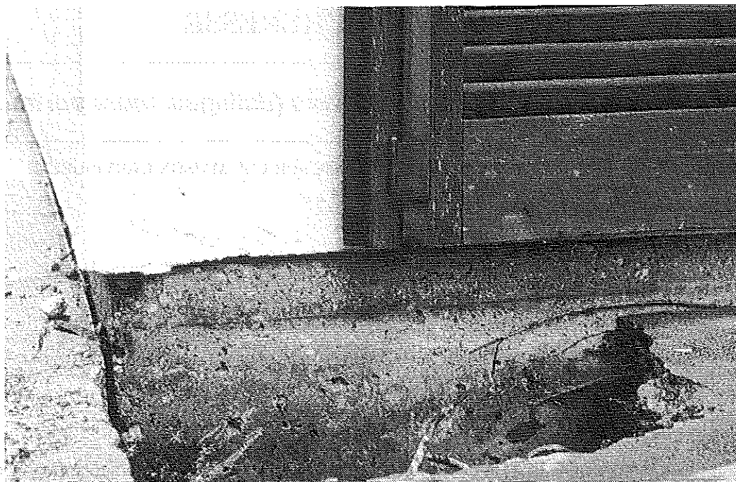
Photo 2 : Tassement du dallage par rapport à la fondation. © J. Putatti
