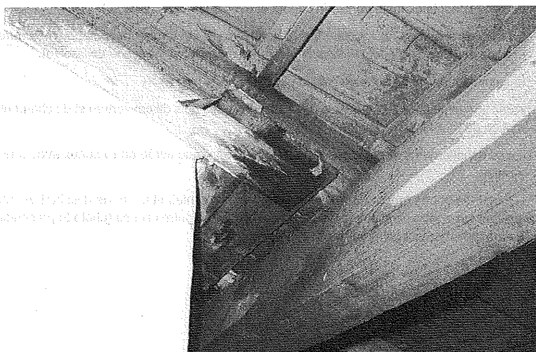
Photo 7 : Début de pourriture des bois de couverture et de charpente. © J. Putatti
