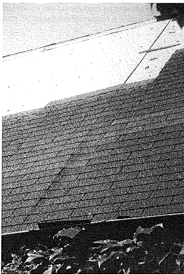
Déformation du plan de versant au droit d'un joint. © J. Putatti
