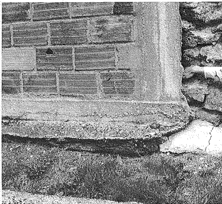
Photo 7 : Détail joint/fondation. Partie basse : – déplacement latéral du mur ; – mur béton fondé (fondation déchaussée). © J. Putatti
