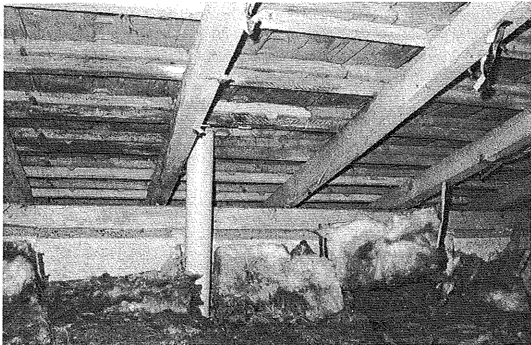
Photo 9 : Après dépose de l'isolant en sous-face, reconstitution d'une isolation par mise en place de l'isolant récupéré sur le plancher du comble. © J. Putatti
