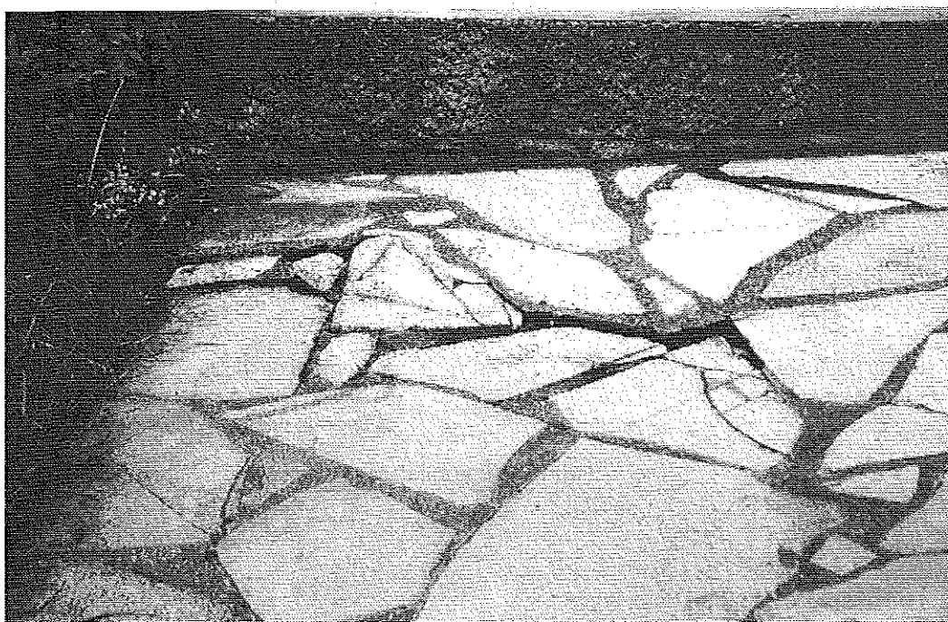
Photo 2 : Dallage extérieur ayant subi : – un tassement d'ensemble (pente de la droite vers la gauche) ; – une fissuration avec effondrement d'une zone de dallage (joints ouverts). © J. Putatti
