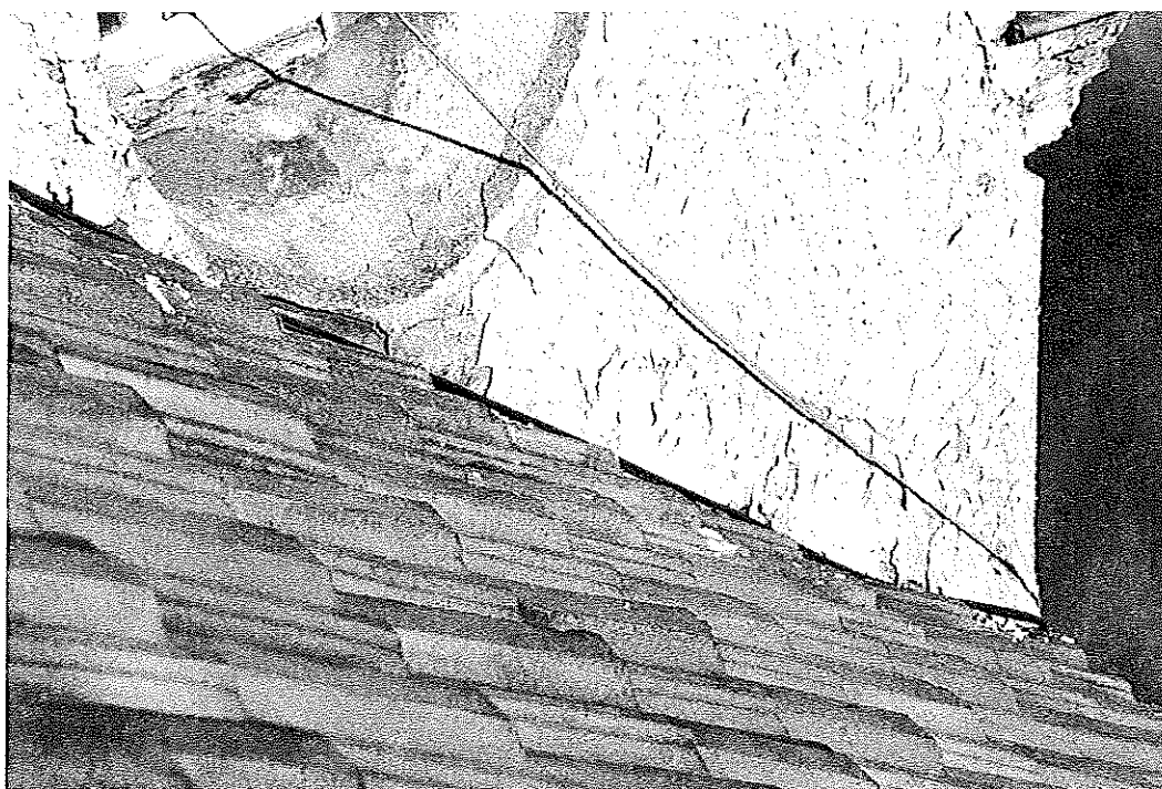
Photo 8 : Versant côté rue. Partie basse. Absence de solin au droit de la lucarne ronde. Noter la pièce d'appui de la fenêtre en très mauvais état. © J. Putatti
