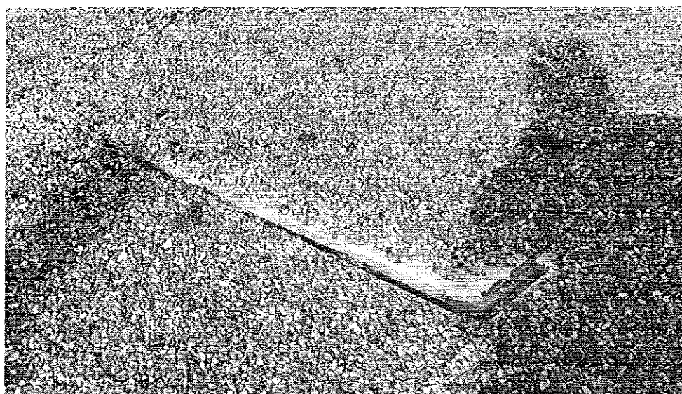
Protection lourde (gravillons) meuble déplacée par le vent. Panneaux soulevés et déboîtés. © J. Putatti
