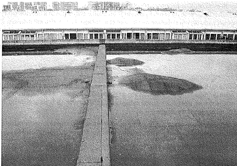
Photo 1 : Terrasse plate étanchéité autoprotégée ; développement de cloques (phase 2). © J. Putatti
