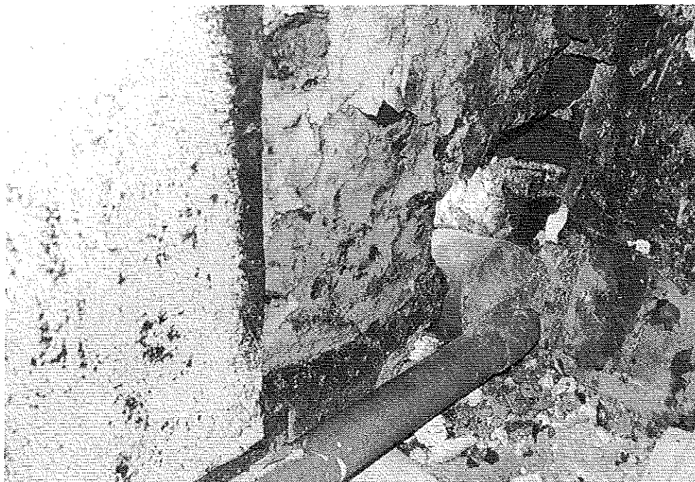
Photo 4 : Modification de l'évacuation tuyau PVC ; raccord mortier spécial. © J. Putatti
