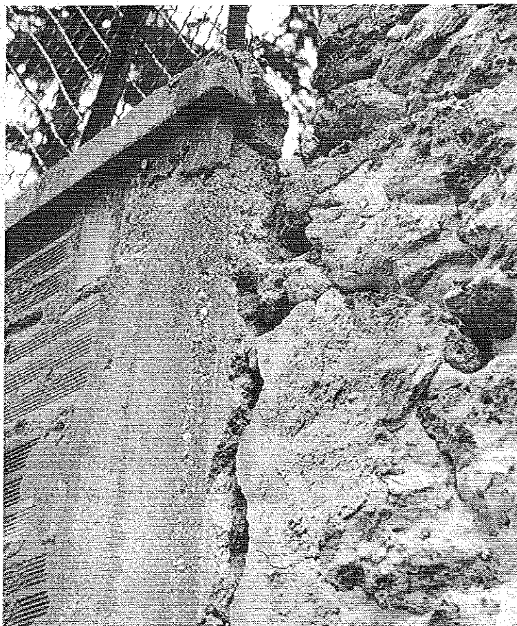
Photo 6 : Détail du joint clotûre/ pignon. Partie supérieure. © J. Putatti
