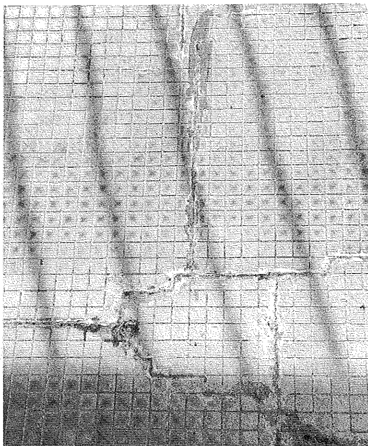
Photo 9 : Remontées de calcite dans les joints de carrelage (7 e étage).
