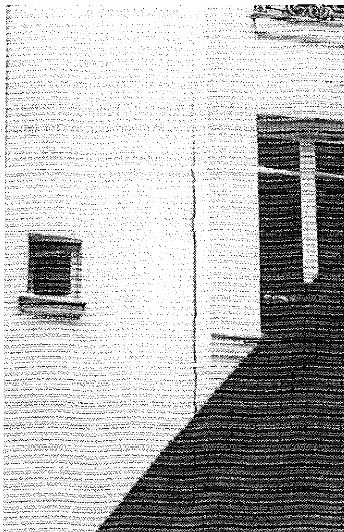
Fissure de décollement (mur latéral cage d'escalier). © J. Putatti
