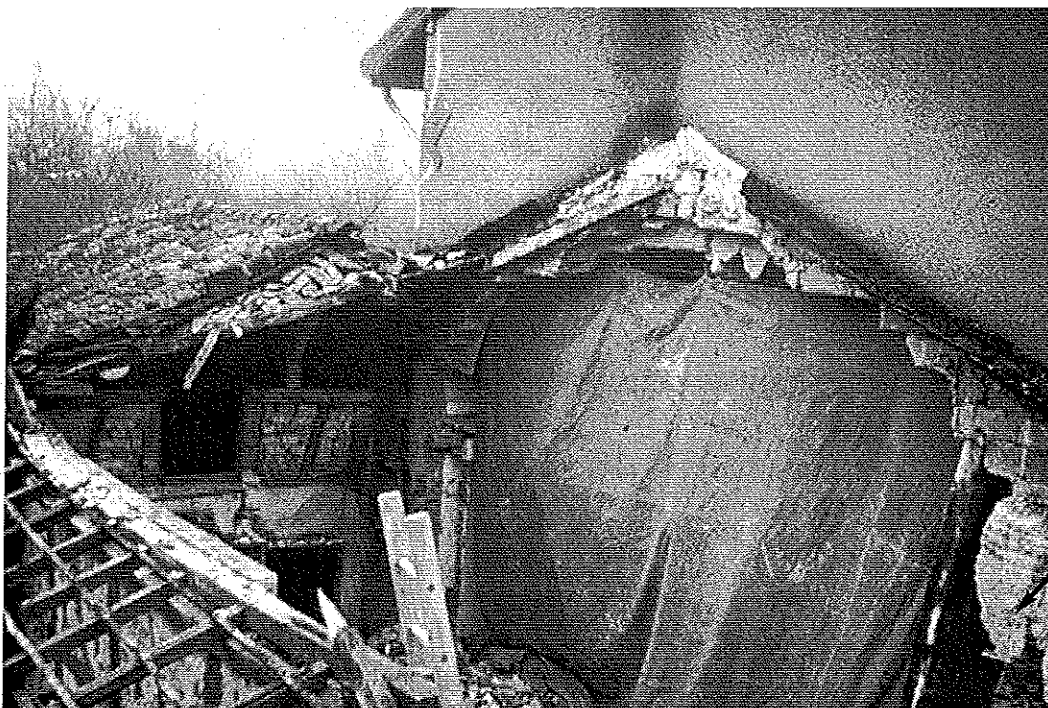
Photo 2 : Détail de la zone effondrée (la flèche indique la maçonnerie de pisé restante). © J. Putatti
