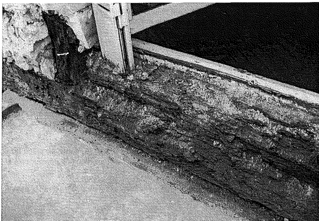
Photo 7 : Détail d'un seuil de porte-fenêtre fortement attaqué au niveau de la poutre-longrine (absence de rejingot et de relevé de la feuille de plomb). © J. Putatti
