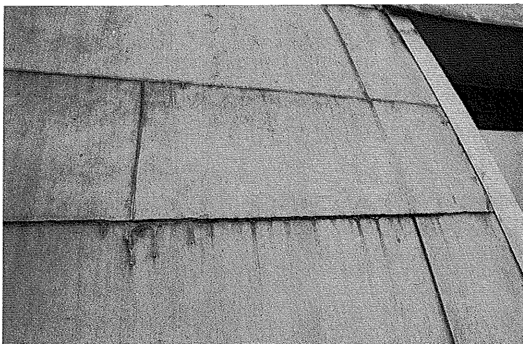
Photo 7 : Détail de la surface des retombées verticales. Jonctions des lés. La colle de confirmation des liaisons présente des coulures saillantes qui accrochent les salissures. © J. Putatti
