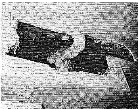
Déviation de la canalisation en plafond
