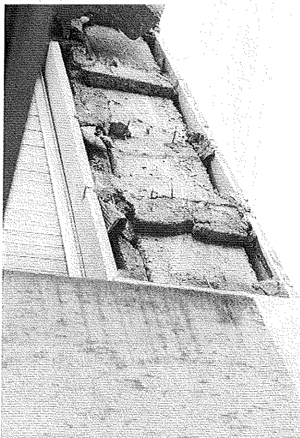
Photo 1 : Angle de mur comportant des dalles détachées. © J. Putatti
