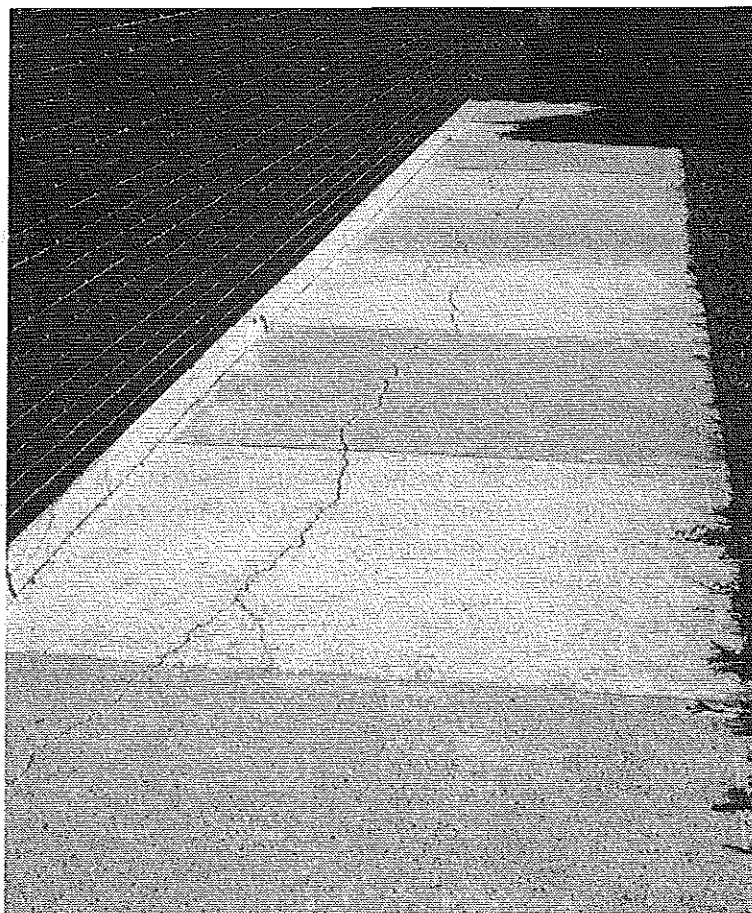
Photo 1 : Fissuration longitudinale d'un dallage extérieur. © J. Putatti
