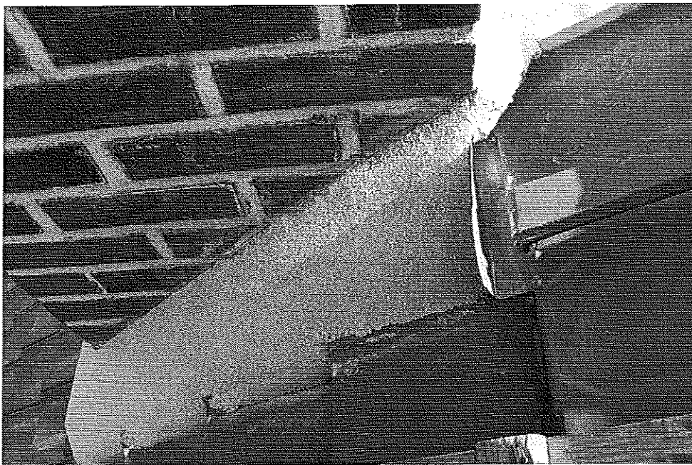
Photo 2 : Détail angle supérieur souche. L'évacuation des tuiles supérieures s'effectue par un canal en zinc. © J. Putatti
