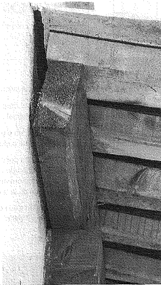
Poutre faîtière. Décollement plus important sur cette rive latérale. © J. Putatti
