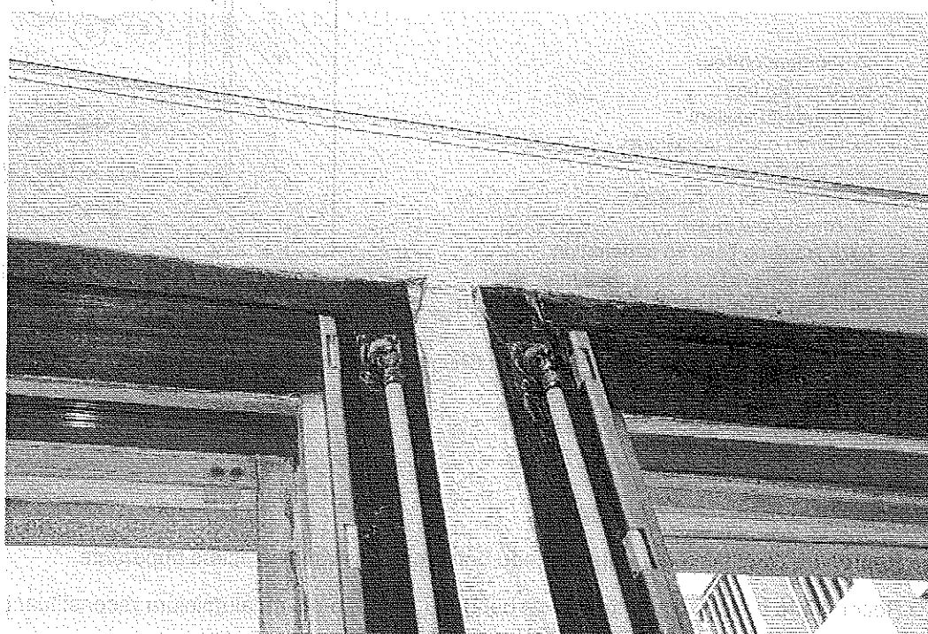
Photo 5 : Désordres intérieurs par pénétrations au droit d'un meneau. © J. Putatti
