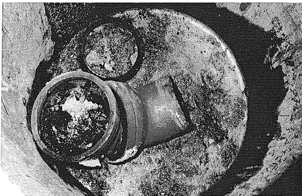
Détail d'un coude (2 coudes au 1/8). Dépôt couvrant la presque totalité de la section
