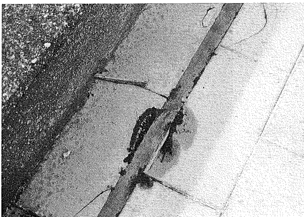
Photo 3 : Éclatement au droit d'un joint de dilatation (détail). © J. Putatti
