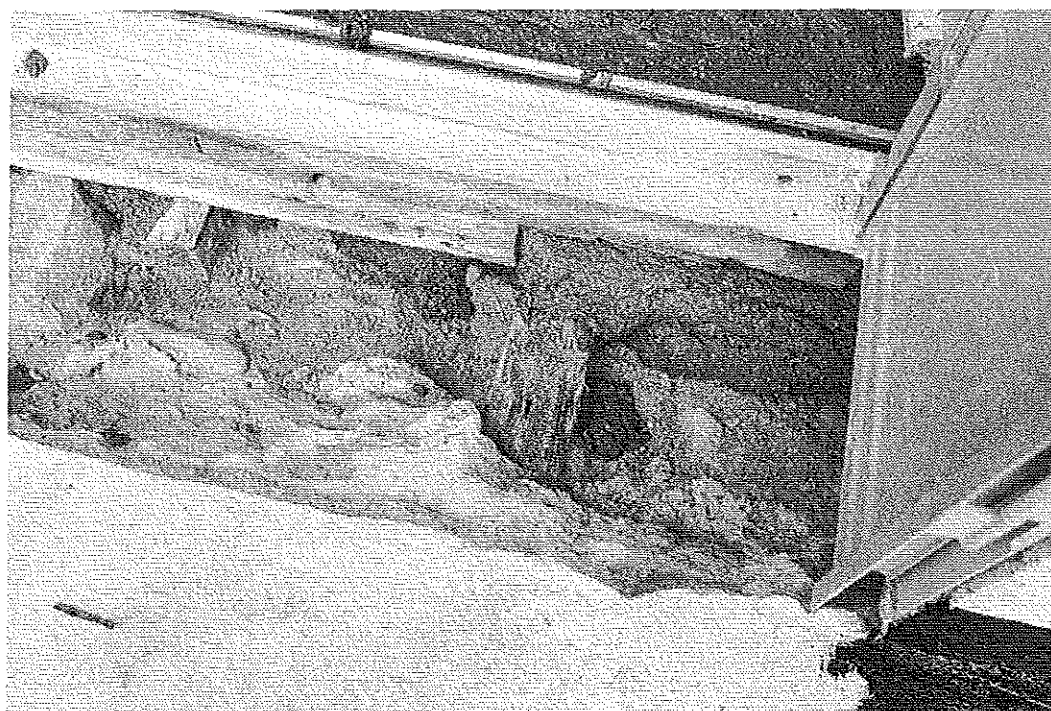
Photo 3 : Détail de la reprise du seuil. Découverte de l'ancienne maçonnerie. Présence de poutre bois de l'ancien plancher. © J. Putatti
