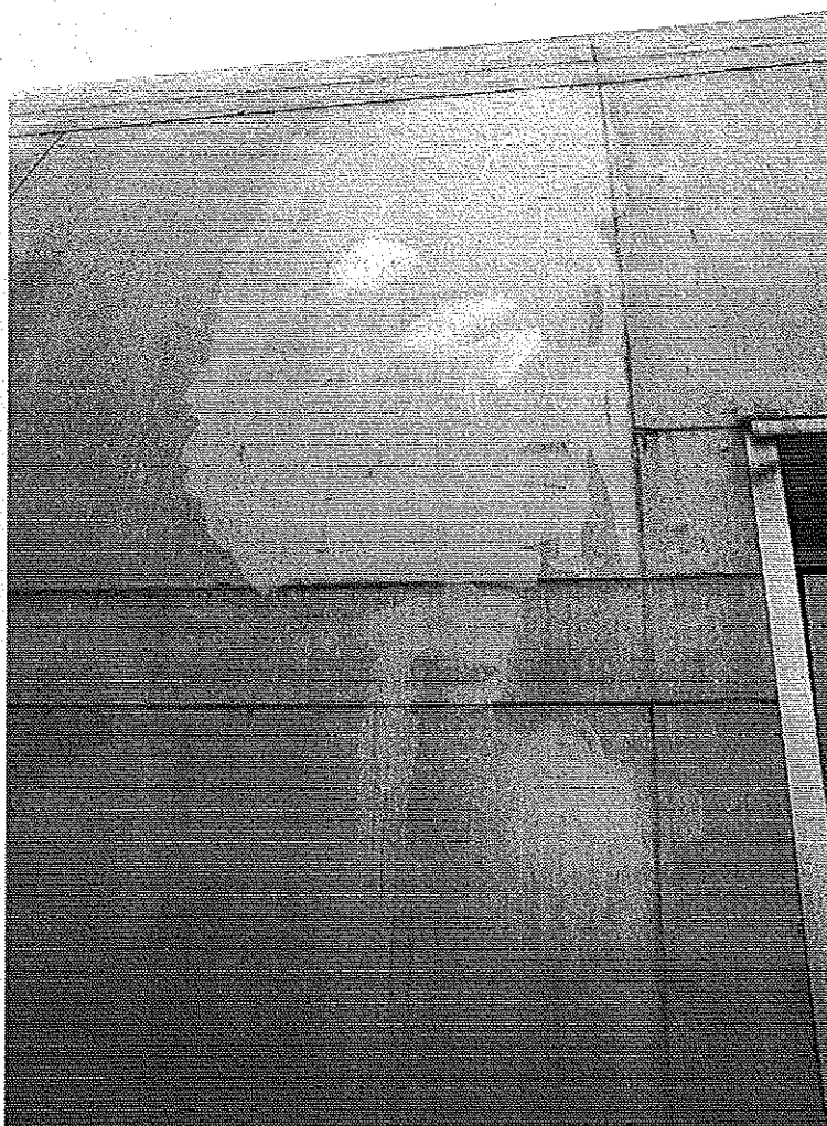
Photo 1 : Essai localisé de nettoyage à l'aide de produits détersifs. © J. Putatti
