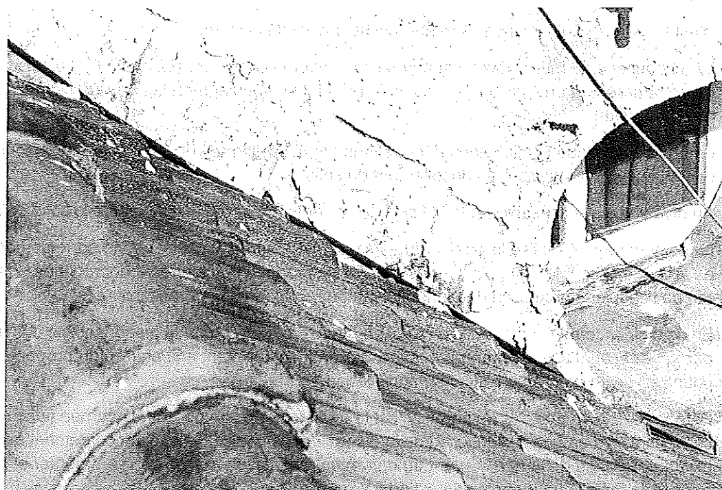
Photo 7 : Versant côté rue. Couverture d'origine conservée. Présence d'une lucarne ronde au ras de la pente (jour de souffrance). Solin fissuré. © J. Putatti
