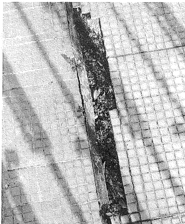
Photo 7 : Dégradation du carrelage au droit d'un joint de fractionnement du carrelage (terrasse 7 e étage). © J. Putatti
