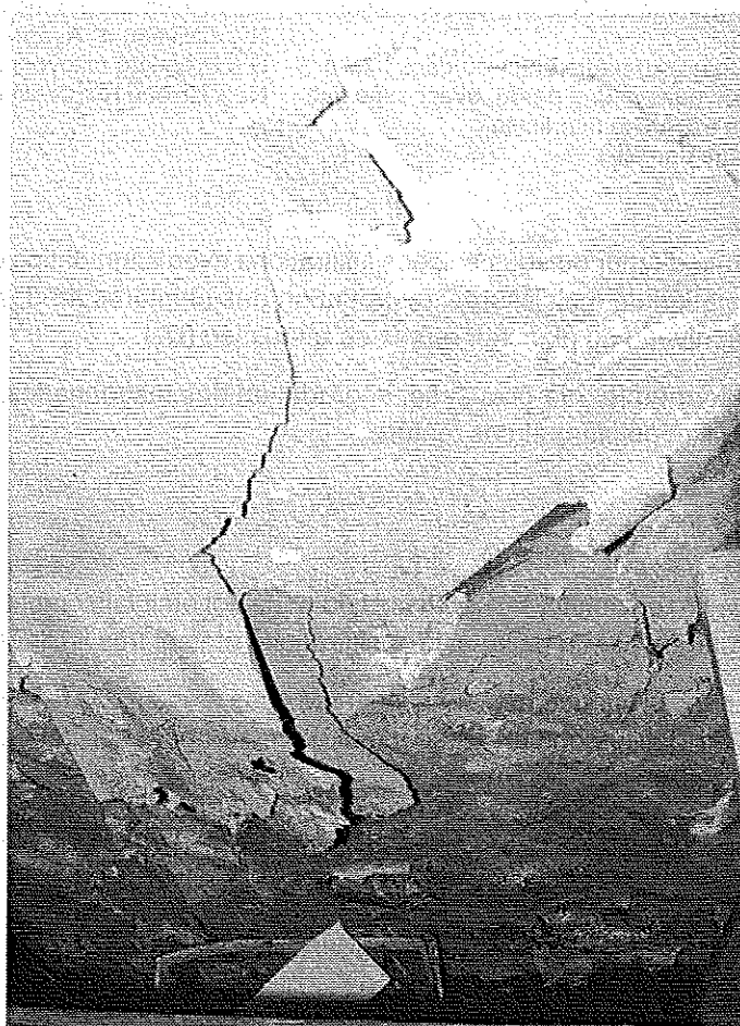
Détail des dégradations dans la hauteur du mur du rez-de-chaussée en limite (vue plongeante) . © J. Putatti
