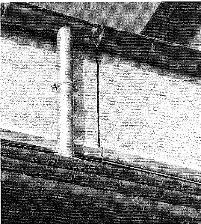
Photo 6 : Détail de la partie haute (comble). La fissure s'élargit vers le haut. © J. Putatti
