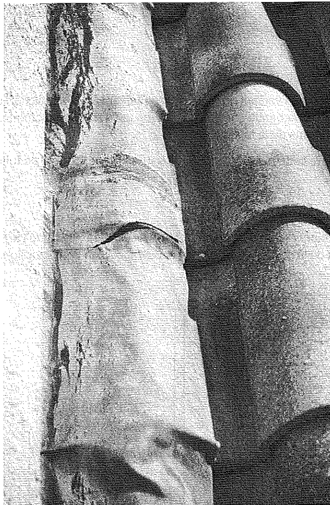
Détail de rive. Fissuration de la feuille de plomb. © J. Putatti
