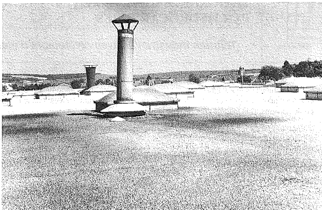
Photo 2 : Autre exemple de toiture industrielle avec extracteurs. Les retombées de poussières grasses s'accumulent à proximité des appareils dans la couche de protection (graviers agglomérés). © J. Putatti
