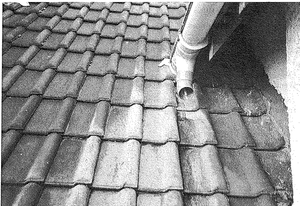
Photo 8 : Déversement de gouttière directement sur le versant principal (gouttière en contre-pente du versant), développement de mousses, risques de remontées capillaires. © J. Putatti
