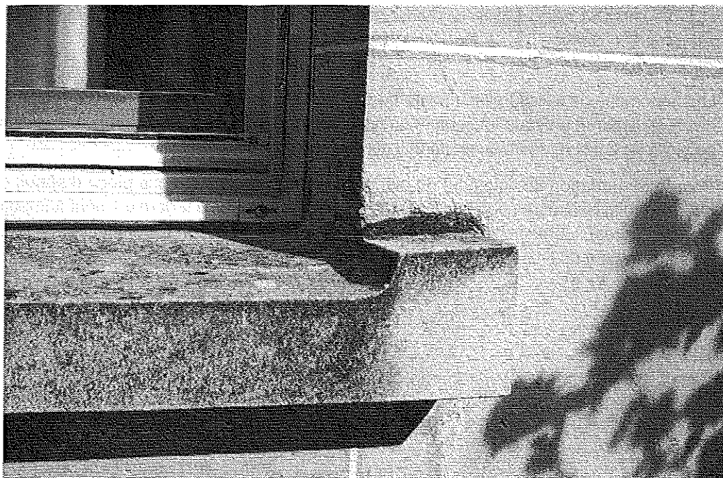
Photo 1 : Appui de baie sur allège en pierre dure. Salissures et dégradation du joint. © J. Putatti
