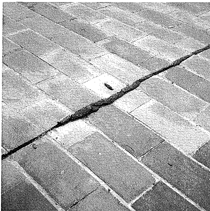
Désordre de joint de fractionnement. © J. Putatti
