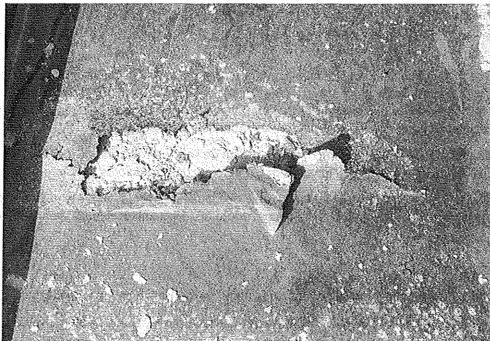
Joint transversal de panneau. Oxyde de zinc apparent entre feuille de zinc et support. © J. Putatti
