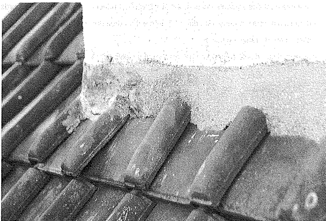
Photo 6 : Détail du solin. Absence d'engravure, calfeutrement par « collage » au mortier et rajout de mastic, tuiles « bancales ». © J. Putatti
