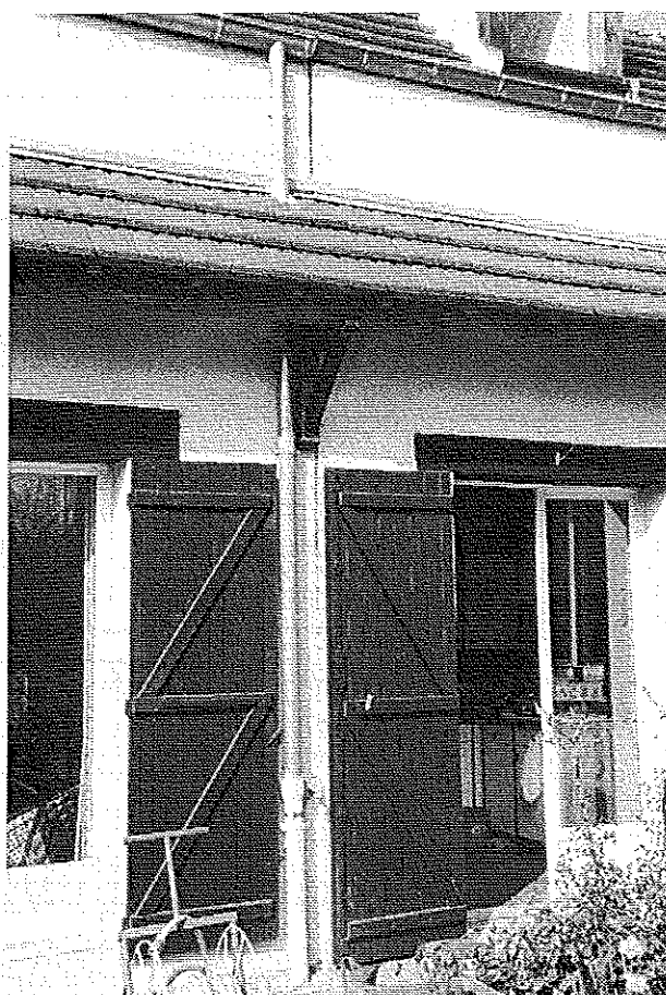
Photo 1 : Jonction des deux parties, fissure près de la descente EP. © J. Putatti
