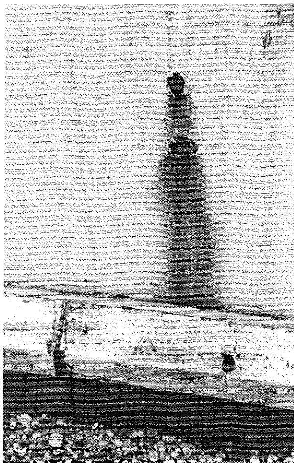
Traînées brunâtres résultant de deux granulats de pyrite. © J. Putatti
