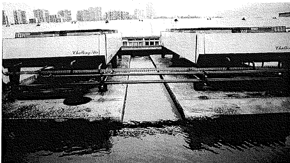
Photo 1 : Les équipements reposent sur des dalles coulées sur place, de grandes dimensions (poids propre 300 daN/m 2 ). L'écoulement et évacuation des EP ne peut s'effectuer (eau en permanence). Les conditions de vieillissement de l'étanchéité conduiront inévitablement à sa réfection et à la démolition avec dépose des équipements. © J. Putatti
