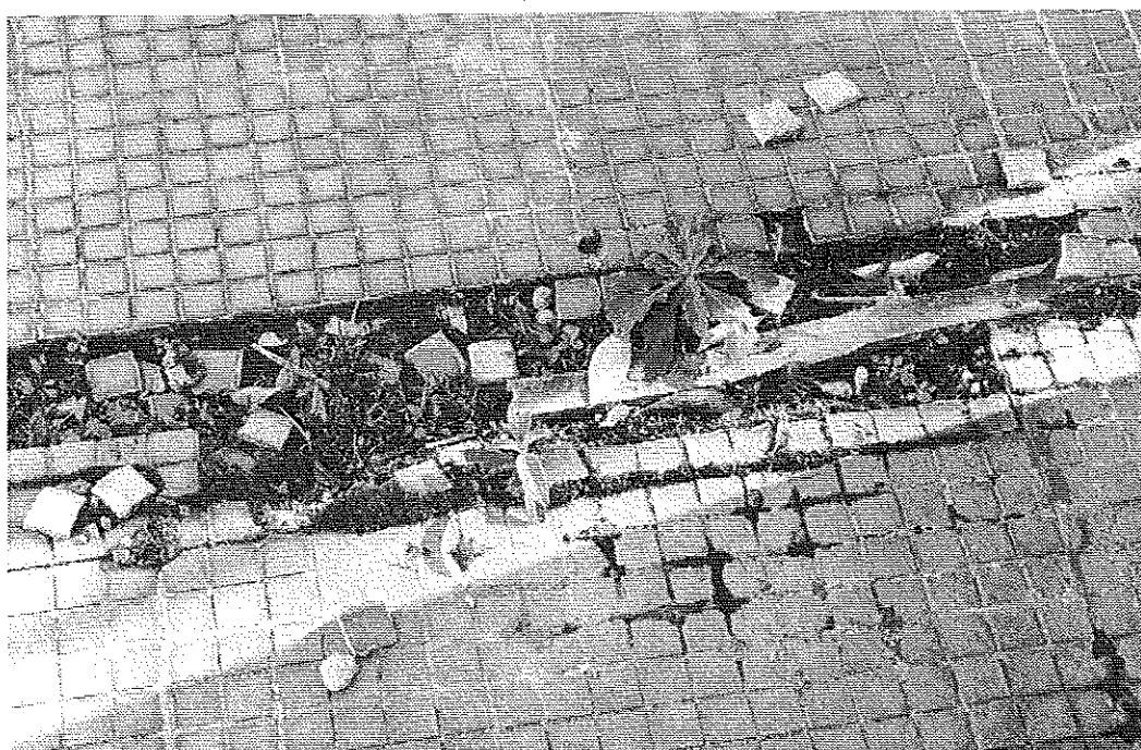
Photo 6 : Zone dégradée du revêtement carrelage (terrasse 7 e étage). © J. Putatti
