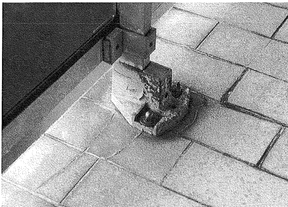
Photo 2 : Désordre au droit d'un piétement de montant de garde-corps : – fissuration au droit de la cheville de fixation ; – fissuration de carrelage, dépôts de calcite dans les joints de carrelage. – altération du métal du piétement. © J. Putatti
