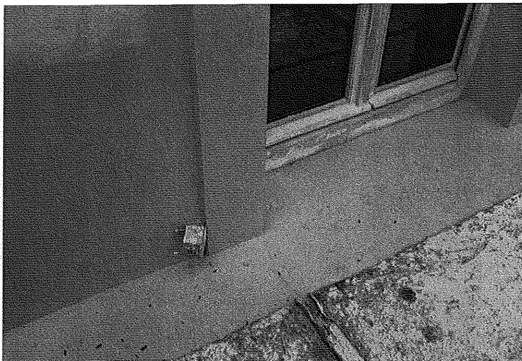
Photo 13 : Aspect final de la façade d'étage en retrait après restructuration de la structure porteuse du pan de bois et réfection des enduits. Préparation des formes en plâtre pour pose des revêtements en feuilles de plomb. © J. Putatti
