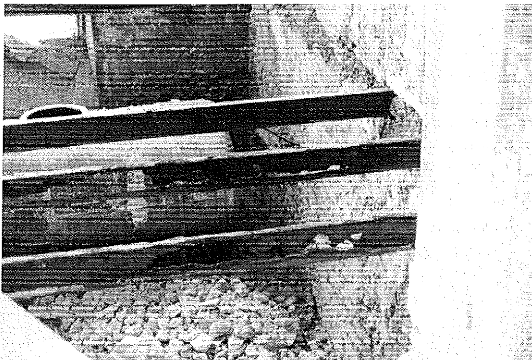
Photo 2 : Détail poutrelles attaquées par la corrosion. Les âmes des poutrelles sont entièrement détruites. © J. Putatti
