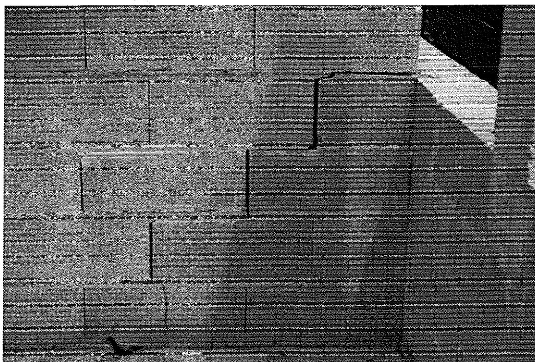
Photo 10 : Cas de figure analogue (cf. photo 9) sur autre refend (fissure traversante suivant le contour des joints de hourdage). © J. Putatti
