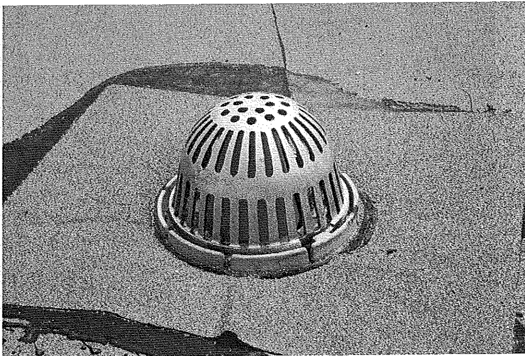
Photo 3 : Entrée d'eaux pluviales en fonte d'aluminium à débit contrôlé (Canada). Raccordement difficile et mal exécuté avec un revêtement d'étanchéité. © J. Putatti
