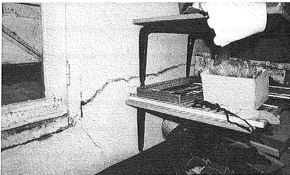
Photo 1 : Fissure longitudinale à la base de la baie (niveau mi-enterré). © J. Putatti
