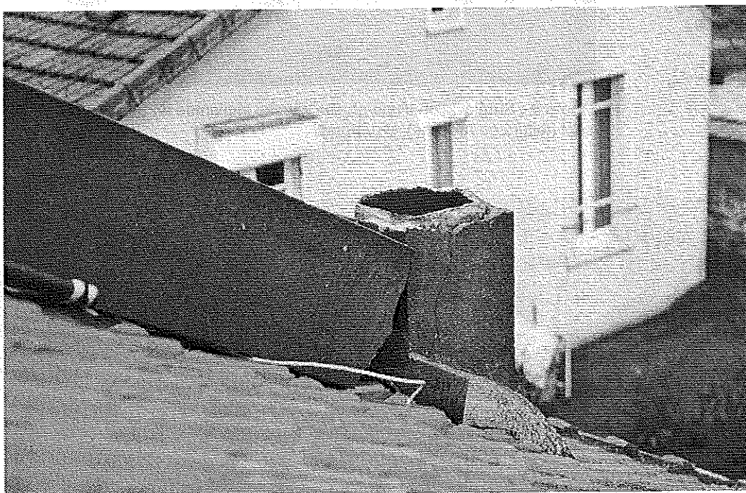
Photo 5 : Détail rupture base de la souche. © J. Putatti
