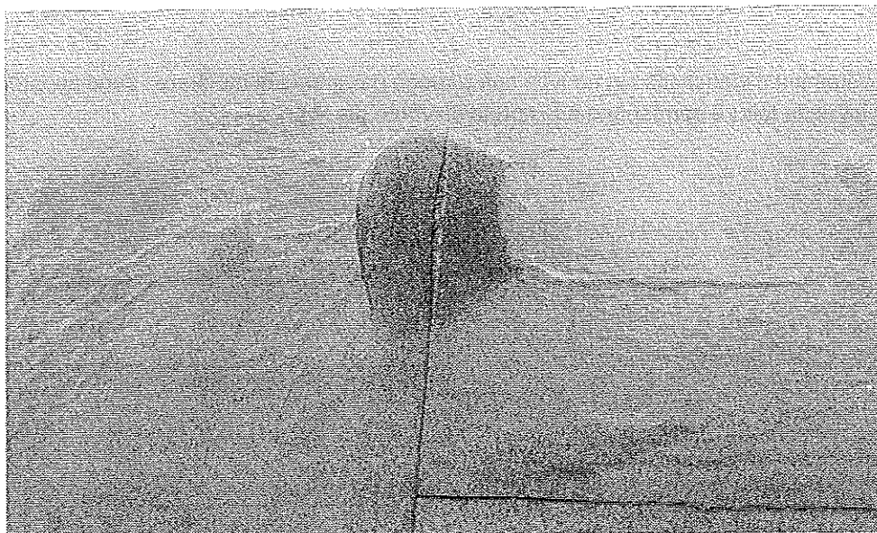
Photo 2 : Cloque en formation noyée partiellement sous l'eau de rétention. Noter l'ouverture du joint de pose du revêtement d'étanchéité. © J. Putatti
