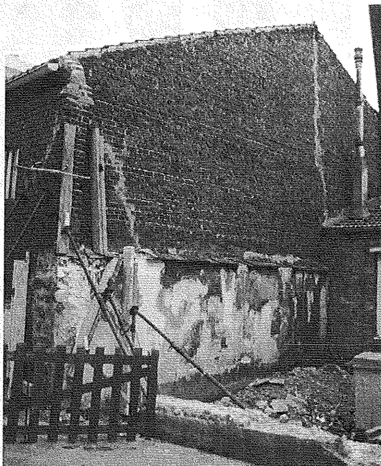
Photo 1 : Ensemble pignon. Fissure verticale au droit du faîtage. Fissures d'angles sur pignon et façade inclinées sur la verticale. © J. Putatti
