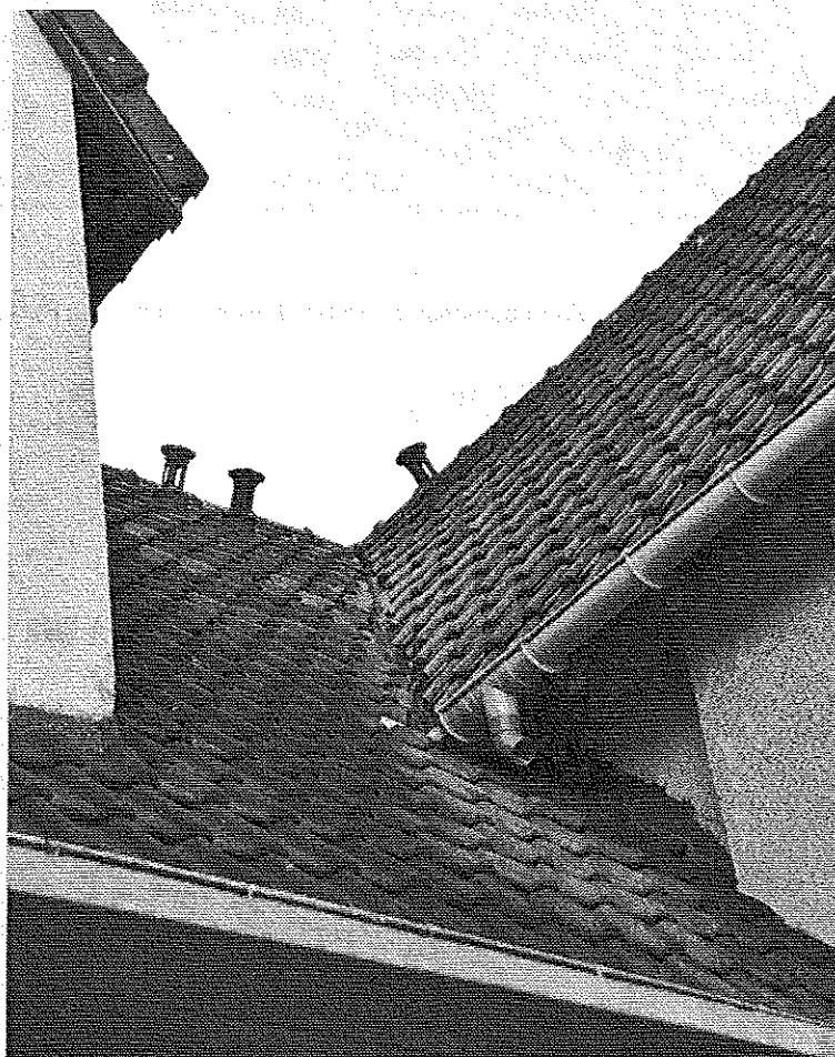
Photo 1 : Versant principal avec lucarne côté gauche et pignon côté droit. Remarquer le tracé de la noue. © J. Putatti
