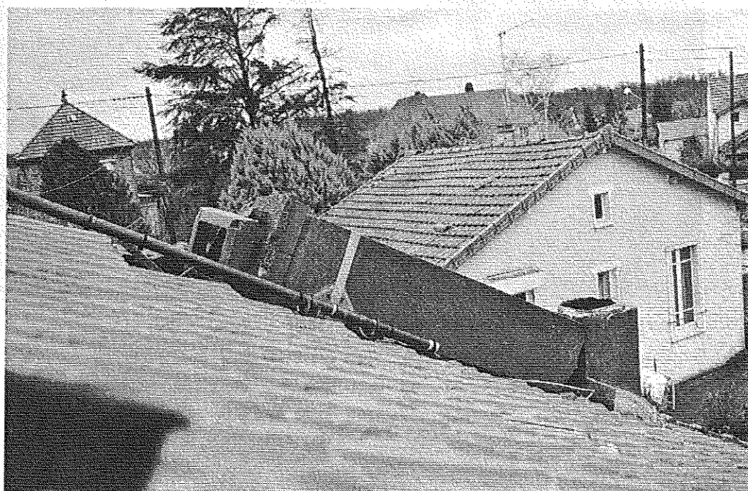
Photo 3 : Rupture d'une souche disposée en bas de versant, au droit d'un joint de boisseau terre cuite (tempête de fin décembre 1999 - Val-de-Marne). © J. Putatti
