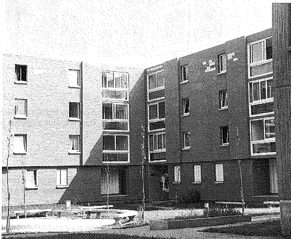
Photo 1 : Ensemble façades ; désordres d'enduit appliqué sur maçonnerie en blocs de béton cellulaire. © J. Putatti
