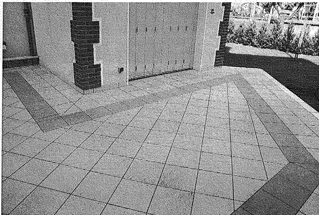
Photo 1 : Terrasse extérieure privative située (en partie) sur la piscine en sous-sol. Noter le seuil inexistant. © J. Putatti
