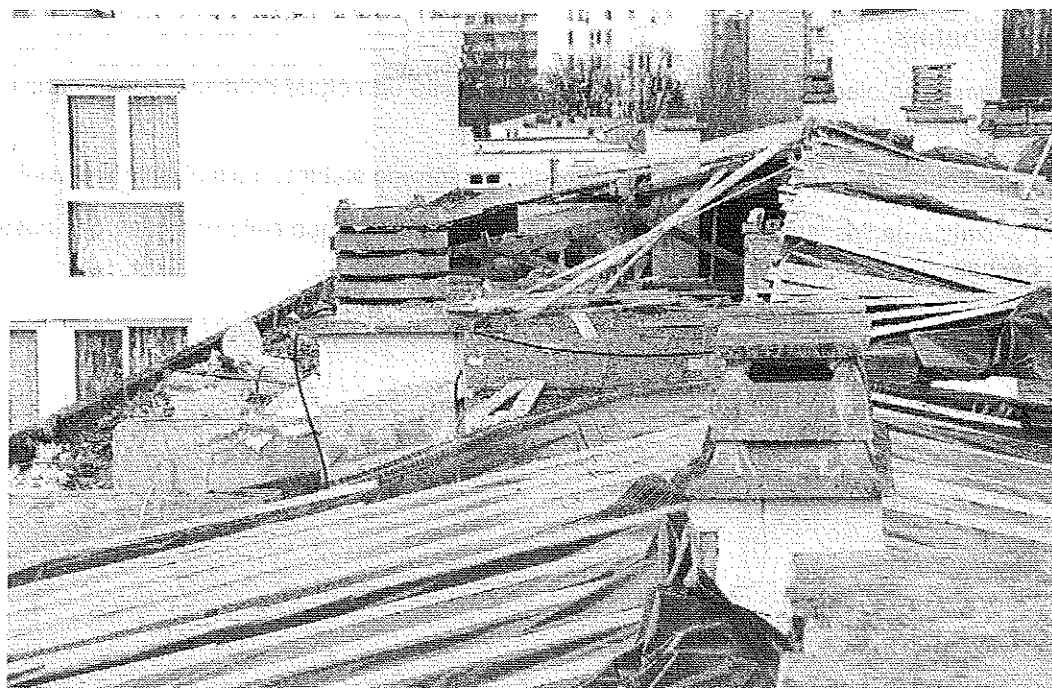
Photo 4 : Détail de la zone du premier sinistre. Zone gauche découverte par suite de l'envol du bâchage provisoire. On aperçoit les fermes de l'ancienne charpente. © J. Putatti
