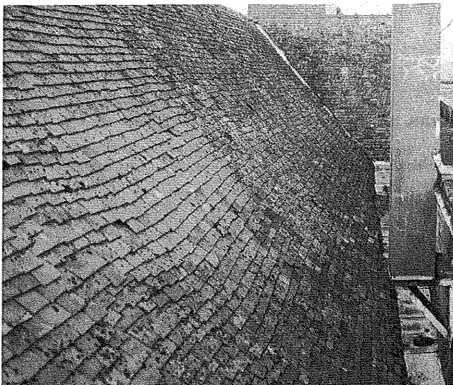
Photo 2 : Versant de couverture en tuiles plates comportant un glissement généralisé des rangs de tuiles avec déboîtement et perte de quelques tuiles. © J. Putatti
