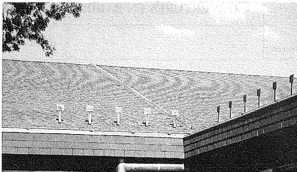
Disposition de joint de structure dans partie courante de couverture en bardeaux. Noter la présence d'arrêts de neige. © J. Putatti
