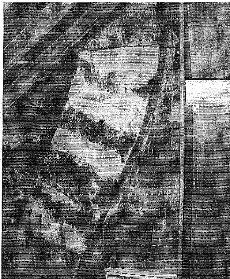
Photo 4 : Détail du conduit en cours de drainage lors d'une forte précipitation. Eau recueillie dans un seau. © J. Putatti
