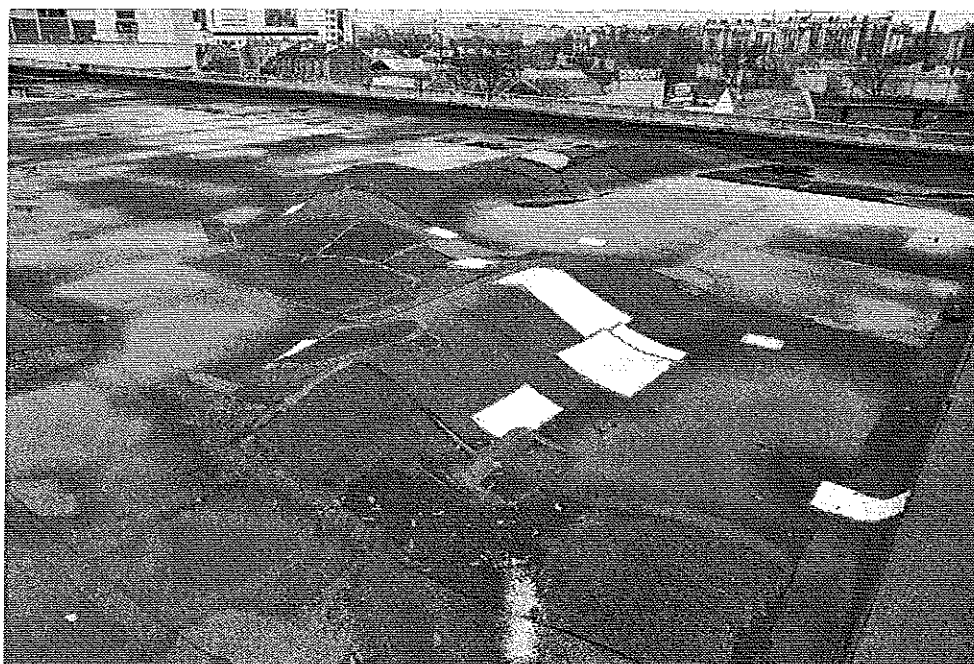
Photo 3 : Cloquage généralisé (nombreuses réparations). © J. Putatti
