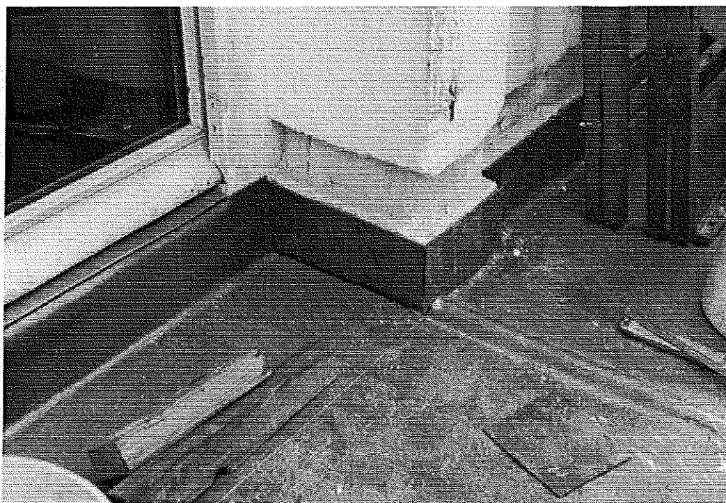
Photo 15 : Détail de réalisation au droit d'un seuil. © J. Putatti
