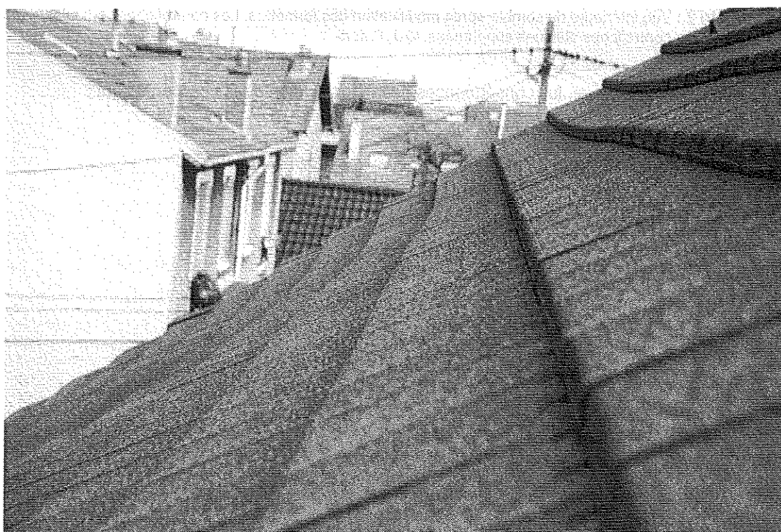
Photo 1 : Déformation d'un versant de couverture en tuiles béton après modification de la charpente. © J. Putatti
