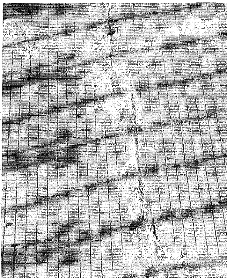
Photo 4 : Concrétions de calcite concentrées sur un joint (7 e étage). © J. Putatti
