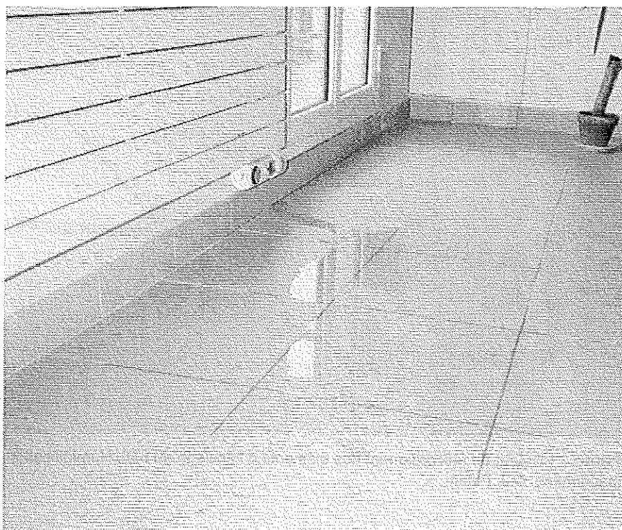
Photo 1 : Pénétration d'eau à partir d'une porte-fenêtre. © J. Putatti
