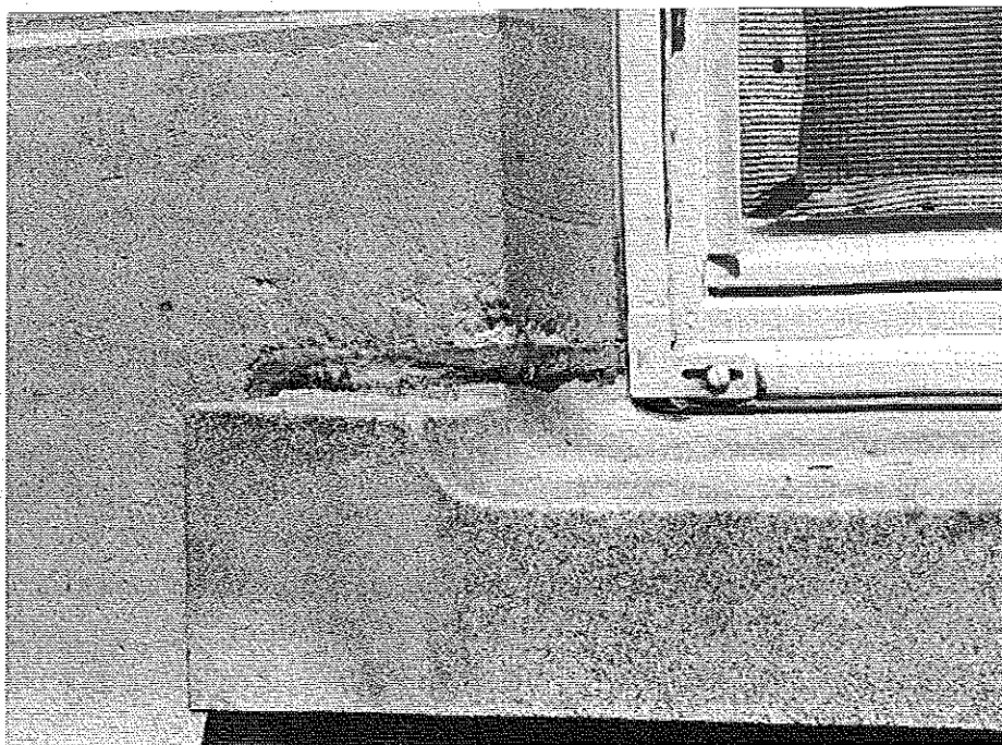
Photo 1 : Côté gauche de l'appui. Détail du joint de la pièce d'appui avec le mur. © J. Putatti
