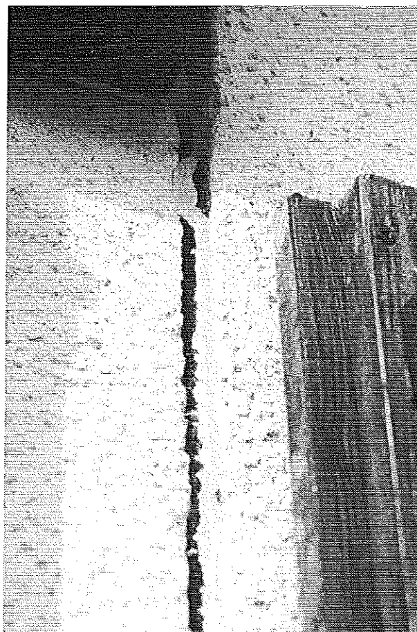
Photo 7 : Détail de l'ouverture du joint fissuré dans la zone sous auvent. © J. Putatti
