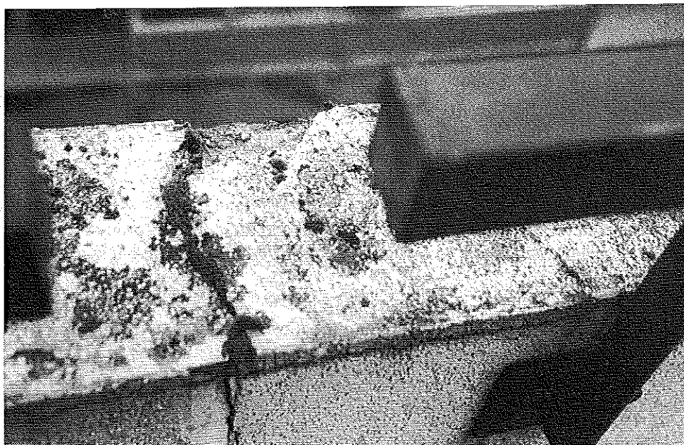
Photo 2 : Fissuration de l'enduit et désagrégation par infiltration et effet de gel (couronnement d'acrotère). © J. Putatti
