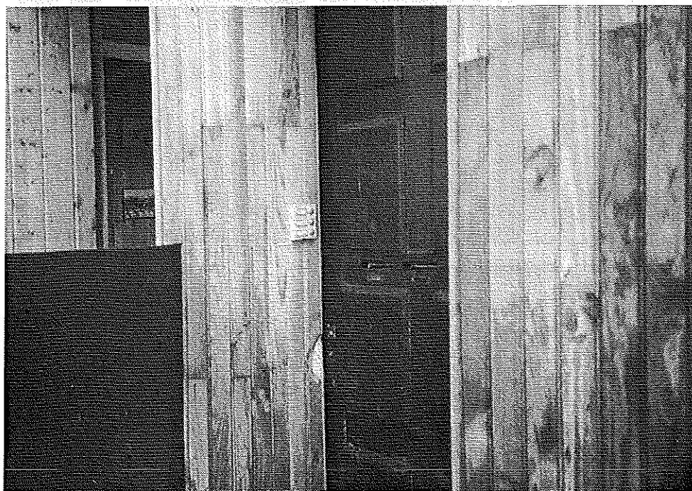
Lambris bleuis exposés aux intempéries sans protection efficace
