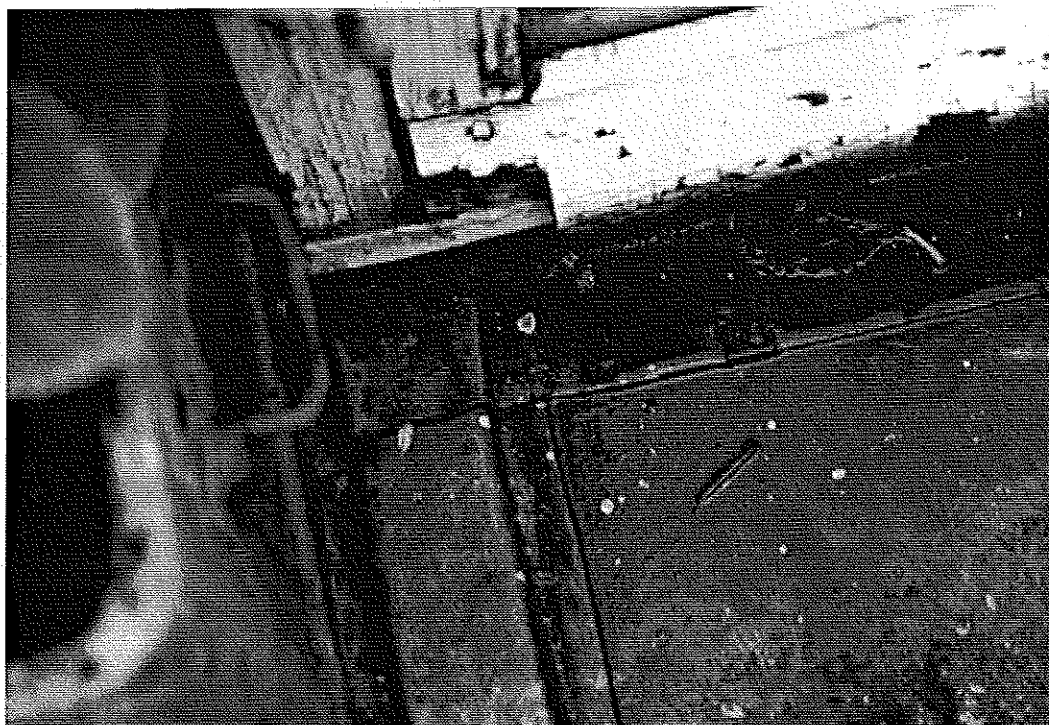
Photo 5 : Détail angle inférieur porte-fenêtre. Présence d'eau stagnante : absence et insuffisance du rejingot. Tasseau à l'angle avec recouvrement des feuilles. © J. Putatti
