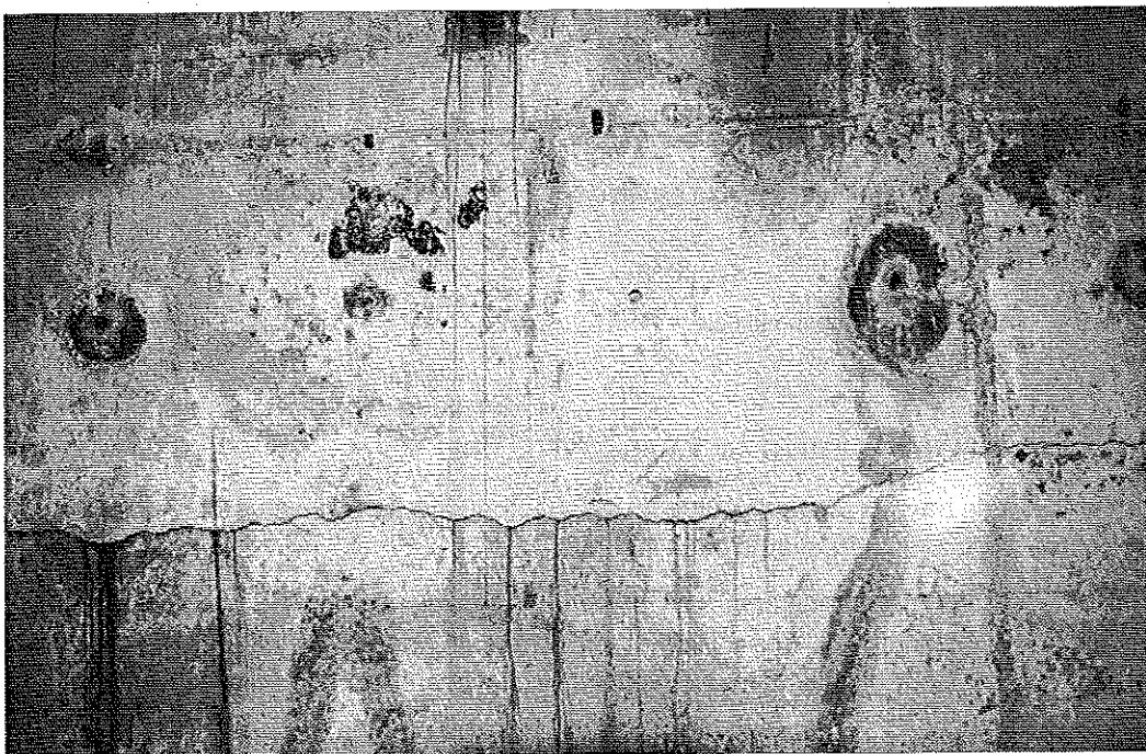
Photo 2 : Aspect de la fissure en zone médiane. Traînées brunâtres de pénétration d'eau chargée. © J. Putatti
