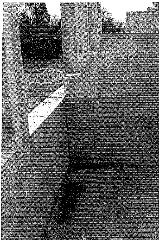
Photo 5 : Détail refend d'étage. Raccordement avec mur allège de l'étage. Fissures des joints de hourdage du refend. © J. Putatti
