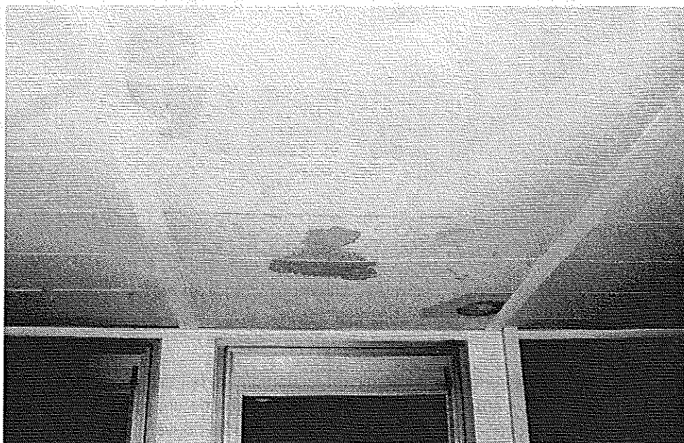
Désordre en faux-plafond, fuites du réseau de canalisation disposé en sous-face de plancher
