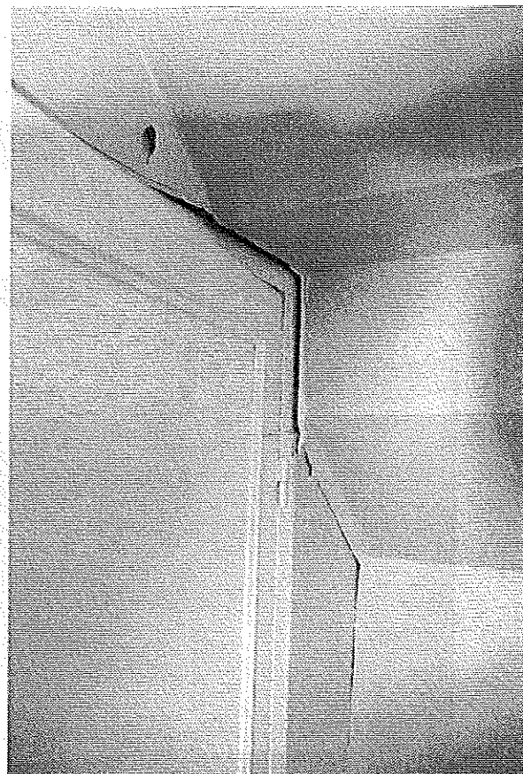
Photo 3 : Fissure de décollement à l'intérieur à l'étage (comble aménagé). © J. Putatti
