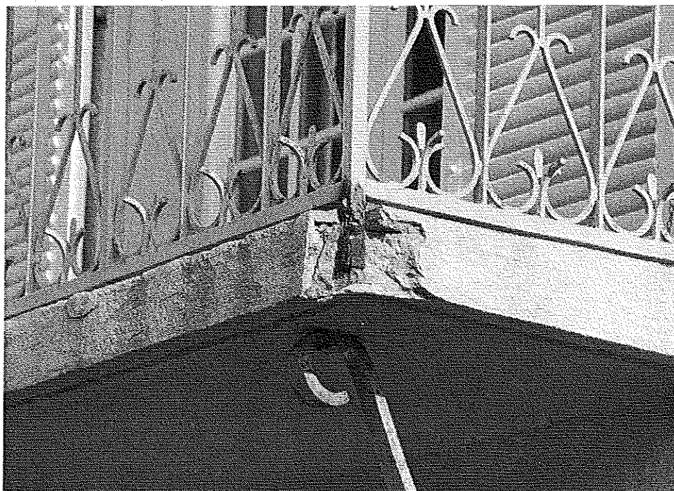
Photo 1 : Éclatement d'un angle de balcon au droit d'un scellement de pied de garde-corps. Insuffisance d'enrobage, effet de la corrosion (expansion de la rouille). © J. Putatti
