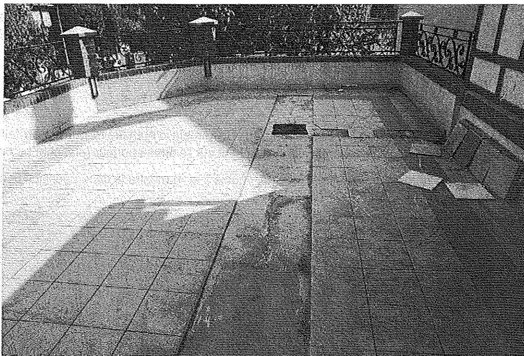
Photo 1 : Vue d'ensemble de la terrasse privative. Zone découverte du carrelage. Sondage pratiqué. © J. Putatti
