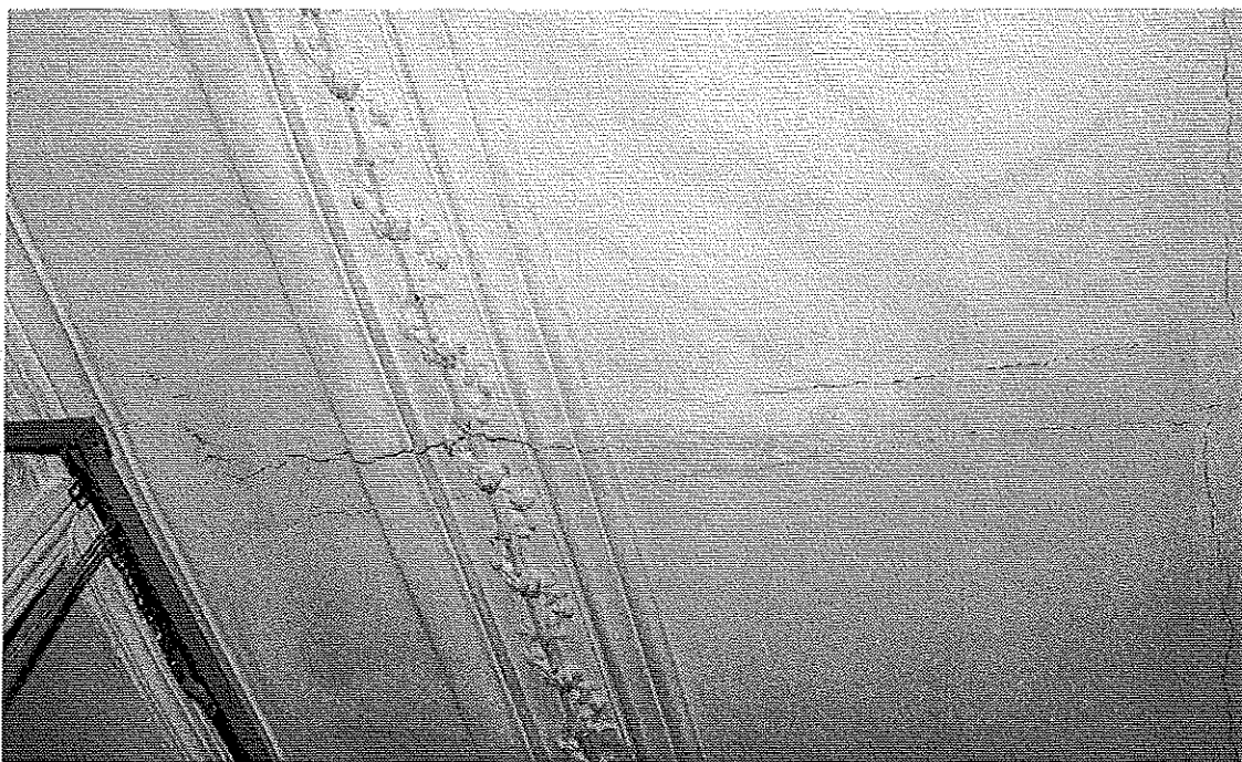
Photo 4 : Fissure double sous une poutrelle métallique et fissure perpendiculaire. Présence d'une corniche décorative. © J. Putatti
