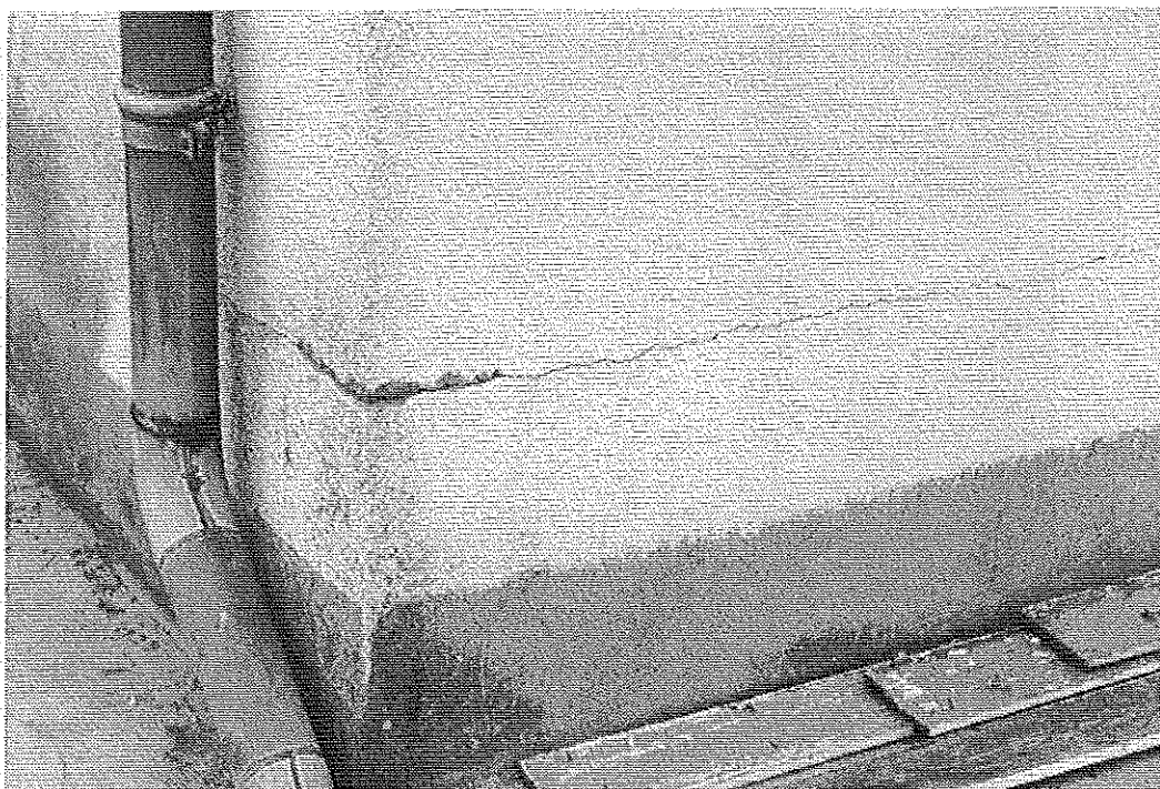
Photo 1 : Fissure d'angle dans une maçonnerie de briques creuses (fissure horizontale). © J. Putatti
