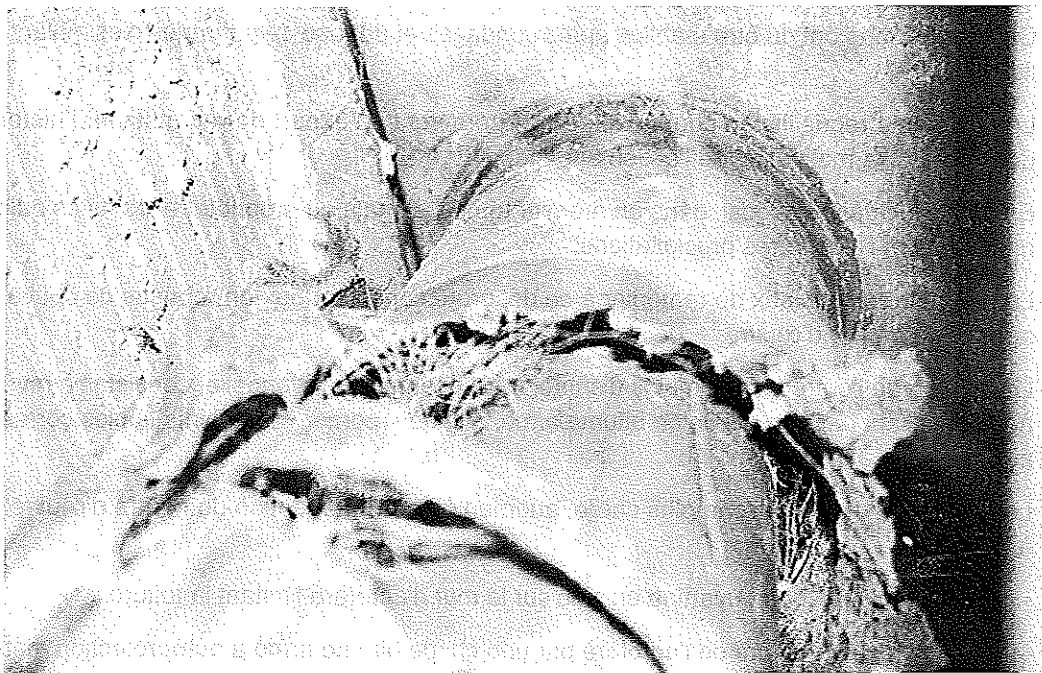
Photo 4 : Ancienne descente EP soudée au chéneau, complètement corrodée et tubée par une canalisation PVC. © J. Putatti
