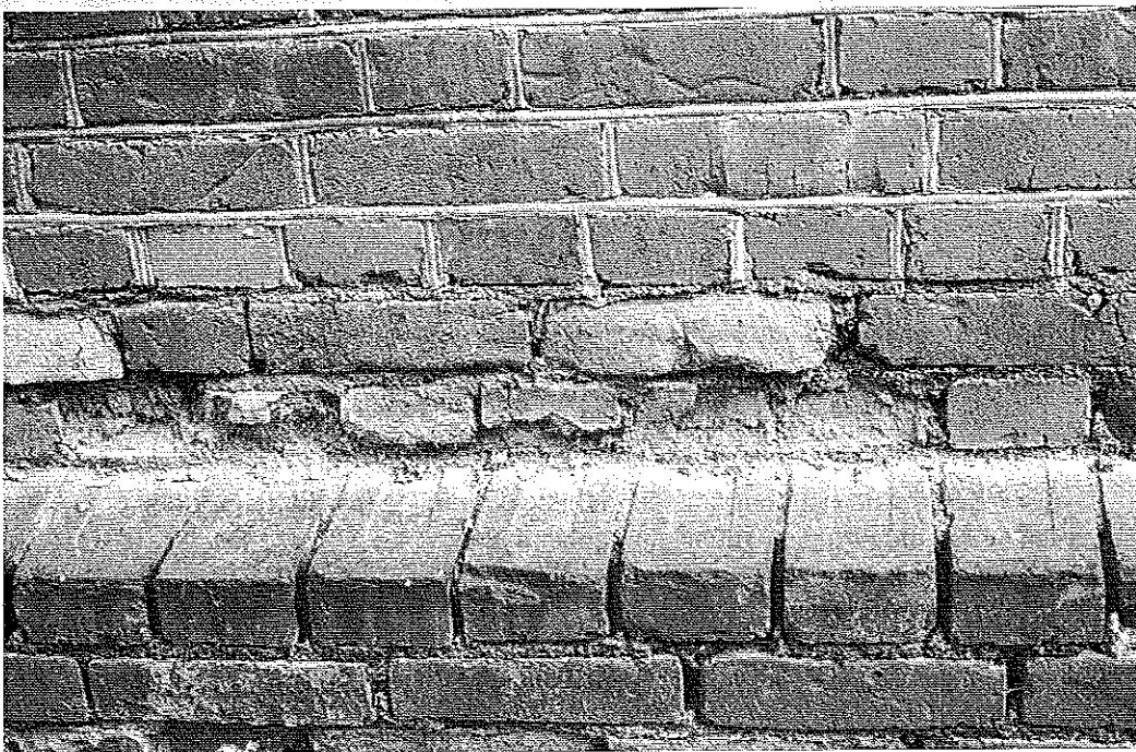
Photo 3 : Maçonnerie de briques pleines porteuses ayant subi les effets du gel. © J. Putatti
