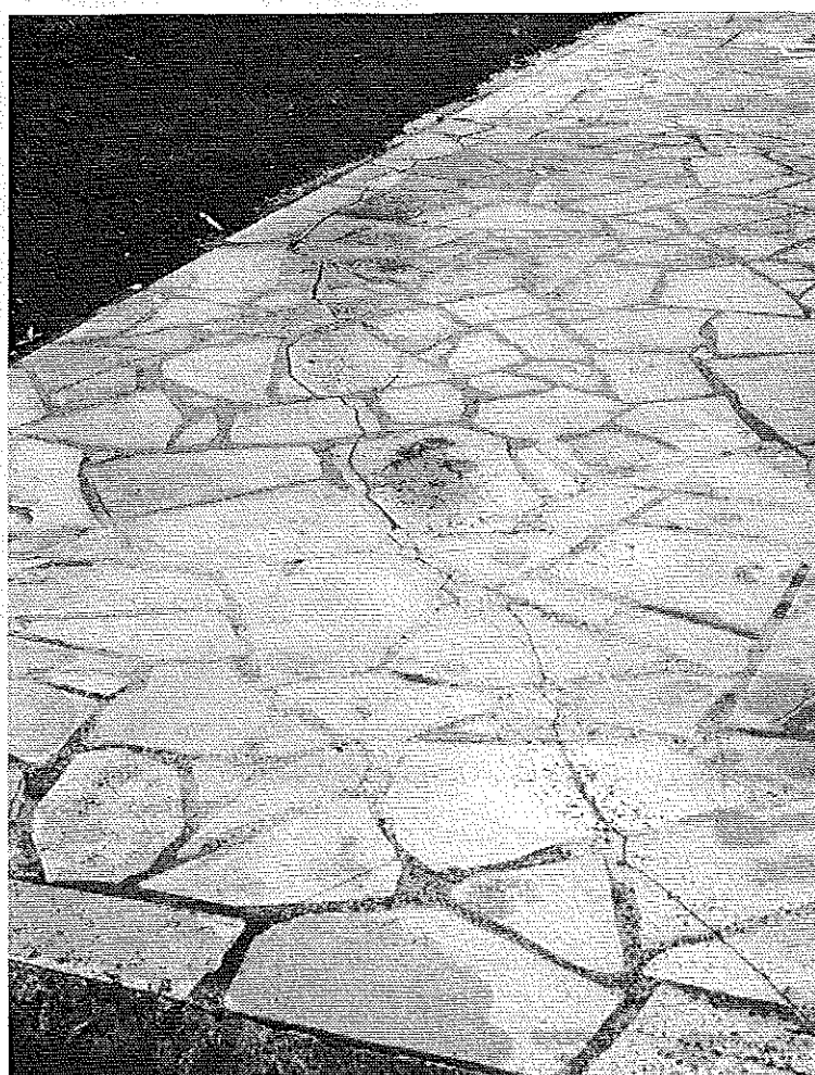
Photo 3 : Fissuration dans un angle de dallage (tassement différentiel). © J. Putatti
