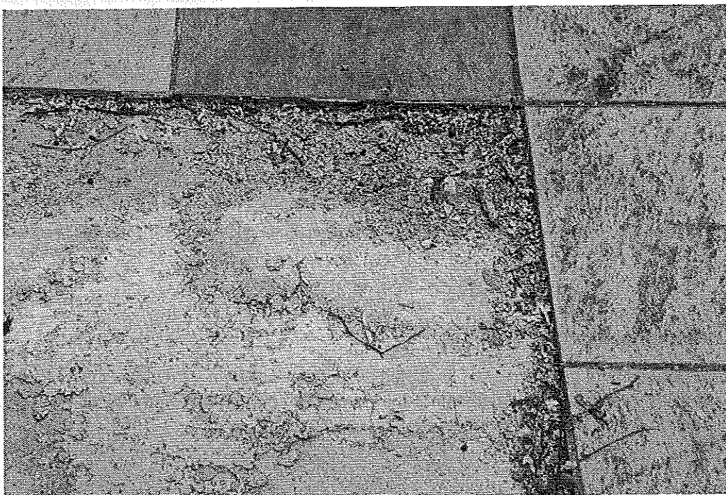
Photo 3 : Aspect du plan de collage. Aucune trace de colle. Débris du film résine réputé étanche (Système d'étanchéité liquide). © J. Putatti
