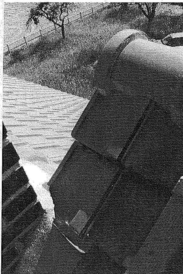
Photo 4 : Détail raccordement souche-couverture et faîtage. © J. Putatti
