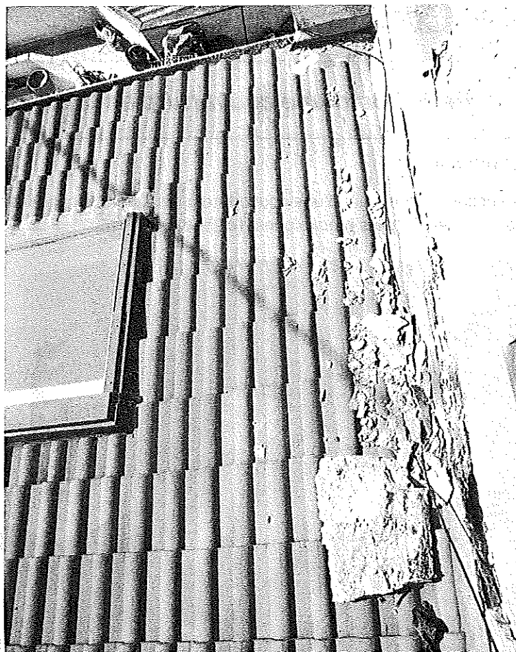
Photo 2 : Versant arrière, solin dégradé. © J. Putatti
