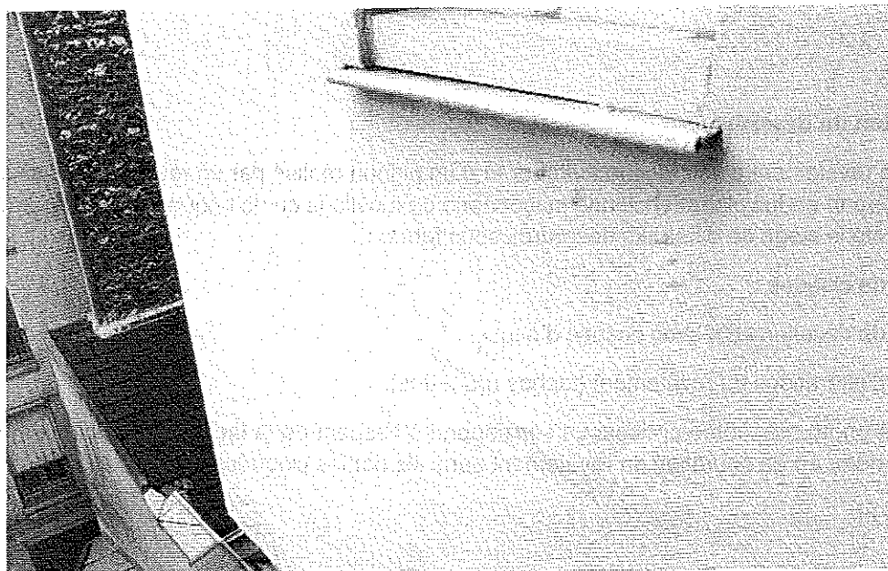
Cloquage du RPE sous un appui de baie. © J. Putatti
