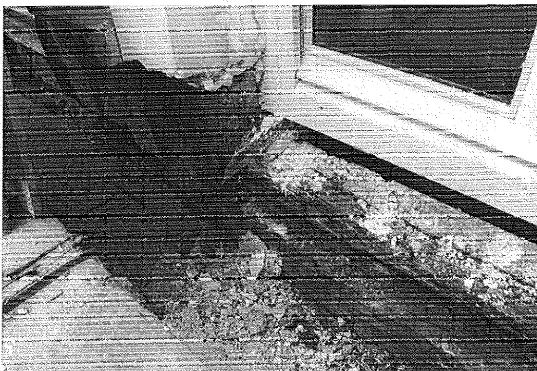
Photo 8 : Disposition d'un seuil après pose d'un bâti neuf de porte-fenêtre. Réserve d'un « jour » pour assurer le raccordement avec la partie extérieure du seuil et la terrasse. © J. Putatti
