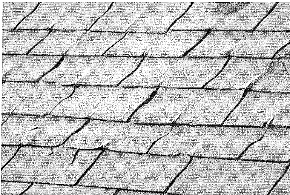
Photo 3 : Détail montrant les vides entre éléments, les déformations dues aux crochets et les effets d'entailles dans les jupes de bardeaux, avec déchirures. © J. Putatti
