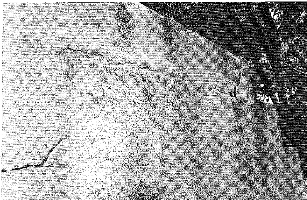
Photo 5 : Détail fissure horizontale entre dallage plage et muret, partie supérieure. © J. Putatti
