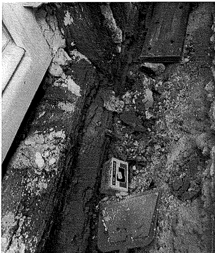
Photo 4 : Zone de destruction partielle : – longrine fortement attaquée ; – pièce de seuil partiellement attaquée ; – poteau de pan de bois fortement attaqué à sa base. © J. Putatti
