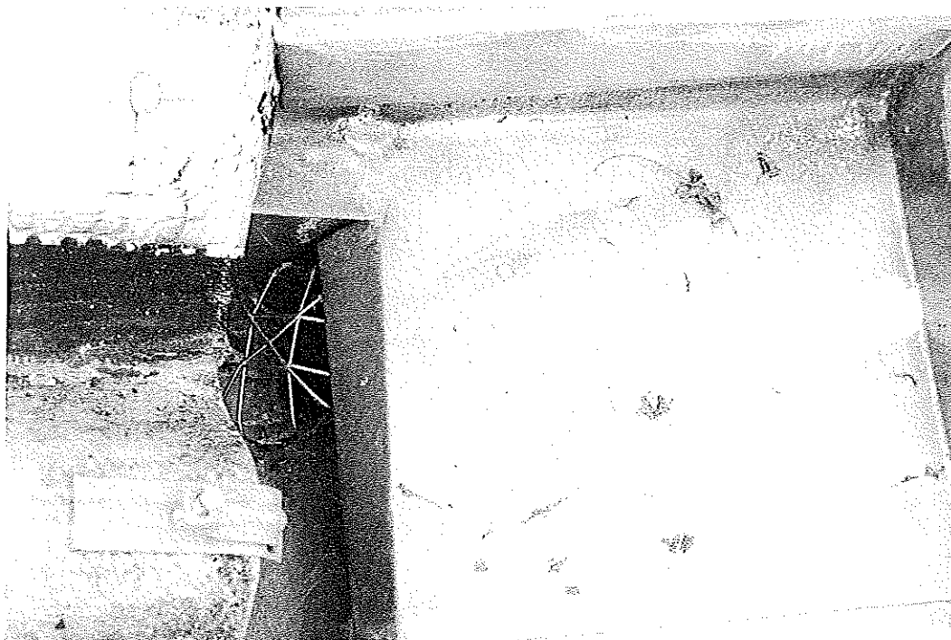
Photo 10 : Raccordement gouttière en about. © J. Putatti
