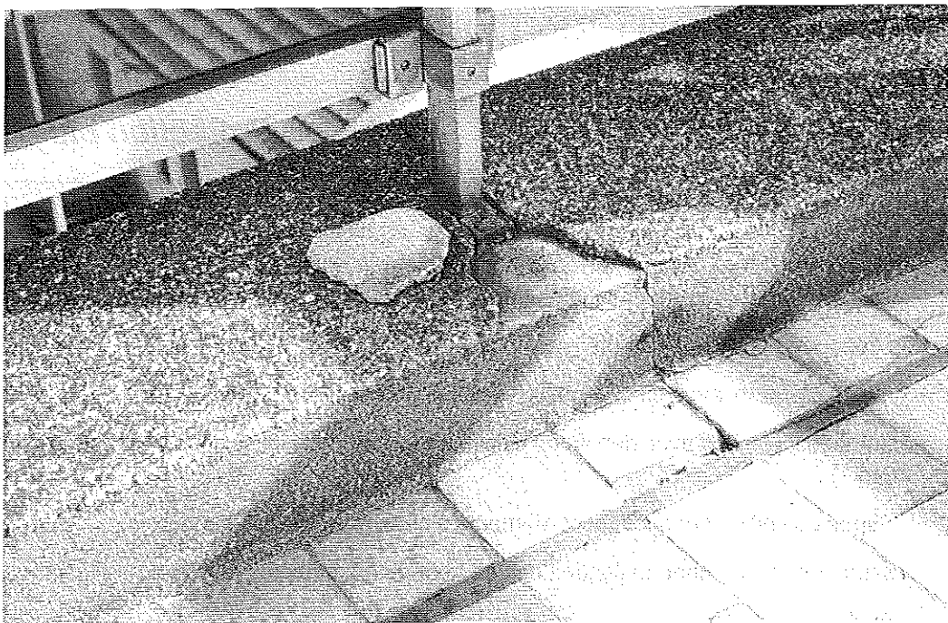
Photo 2 : Éclatement de l'enduit et d'un carreau au droit d'un scellement de garde-corps. © J. Putatti
