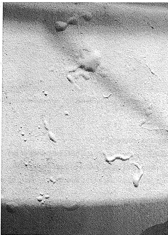
Photo 1 : Cloquage du RPE sur enduit plâtre. © J. Putatti
