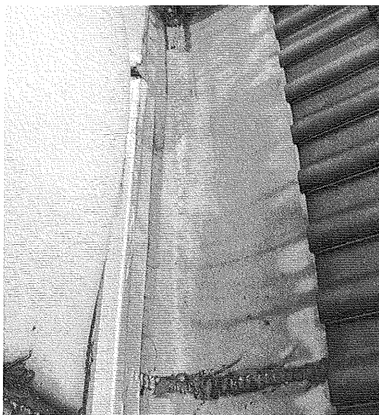
Photo 5 : Soudure de gouttière de qualité « douteuse » formant saillie gênant l'écoulement des eaux. Raccordement par bande adhésive. © J. Putatti
