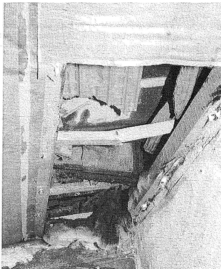
Photo 6 : Vue sous toiture. Rupture des tuiles. Solin et bois de couverture. © J. Putatti
