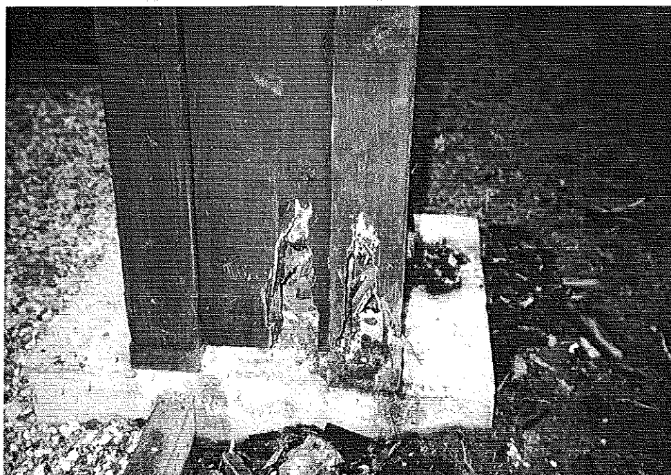
Pied de poteau d'un arc en lamellé-collé dégradé par le champignon lignivore
