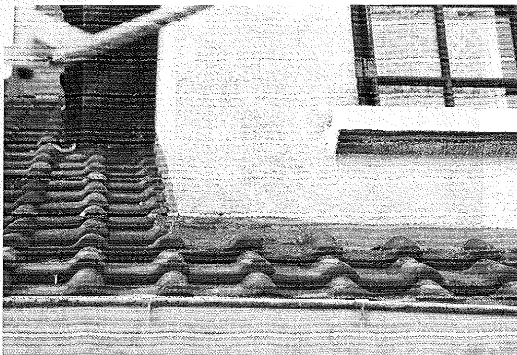
Photo 5 : Réalisation du solin de raccordement du bas de versant avec façade de la lucarne, défaut d'alignement, absence d'engravure, calfeutrement rapporté par mastic. © J. Putatti
