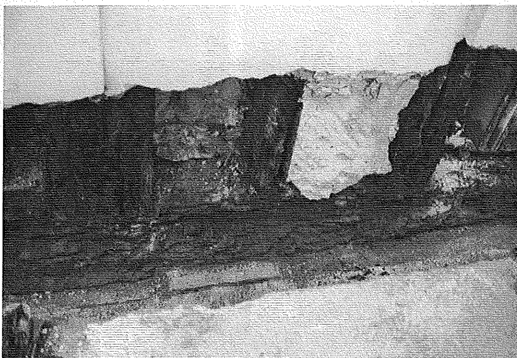
Photo 14 : Zone de pan de bois particulièrement altérée par les attaques de l'humidité. © J. Putatti
