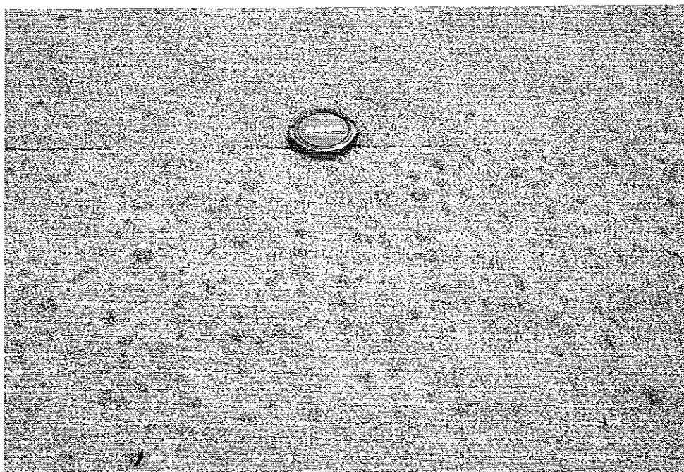
Photo 2 : Même phénomène (chantier différent). Noter la concentration des pustules en bordure d'une feuille de revêtement. © J. Putatti
