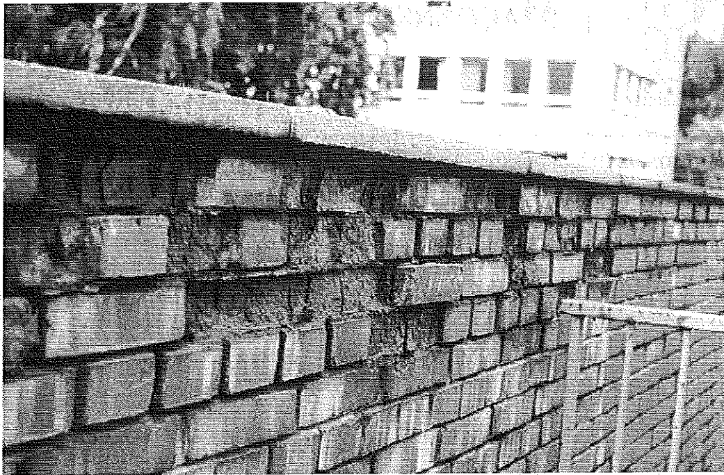
Photo 2 : Phénomène de gel sur une maçonnerie de briques pleines. © J. Putatti
