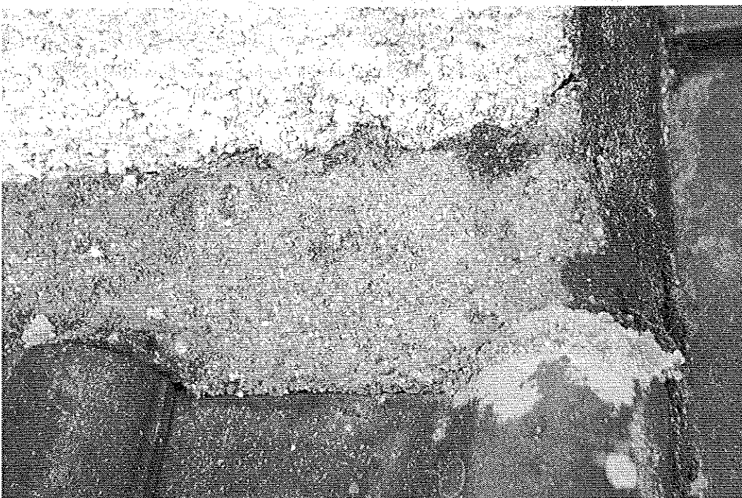
Photo 7 : Détail mortier de solin, fissure de décollement, retrait avec l'enduit du mur lucarne. © J. Putatti
