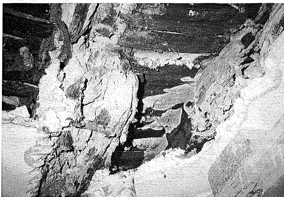
Sollivage en chêne dégradé par le Polypore des caves ; remarquer le mycélium sur le lattis
