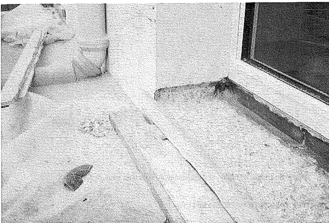
Photo 7 : Disposition analogue. Abaissement du niveau de seuil par repiochage. Remarquer le raccordement de la conduite EP de l'étage en retrait avec une canalisation semi-noyée dans le balcon (?). © J. Putatti
