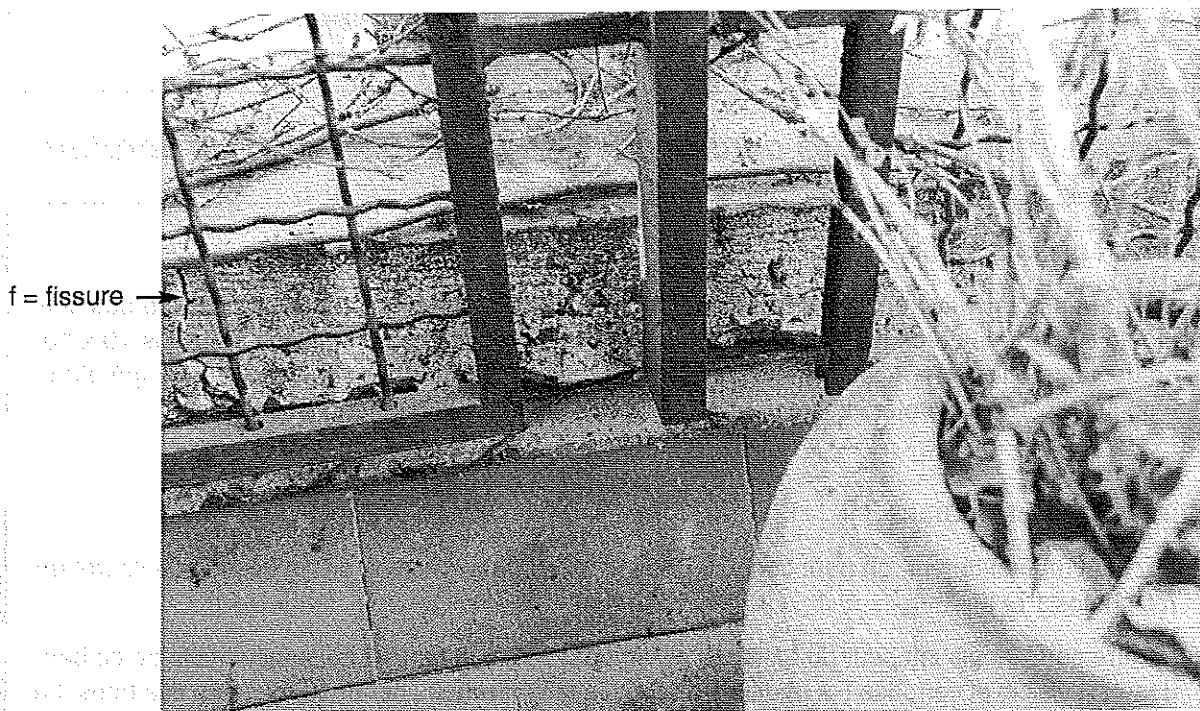
Photo 2 : Détail bandeau saillant. Bordure inférieure éclatée. © J. Putatti
