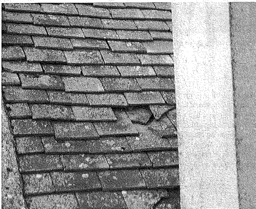
Photo 3 : Glissement de tuiles plates avec casse de quelques éléments. © J. Putatti
