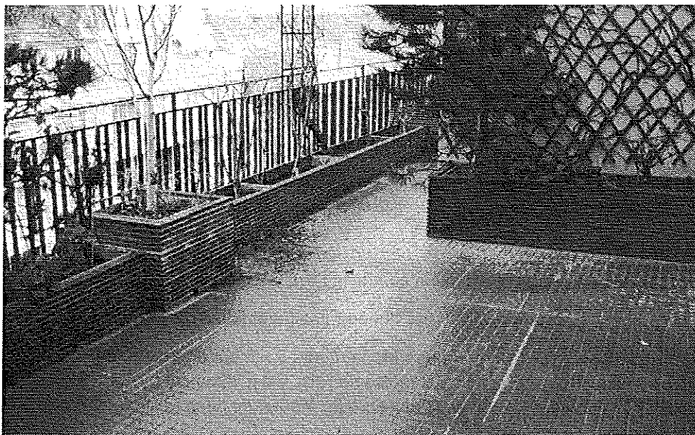
Terrasse accessible privative (étage en retrait). Absence de joints de fractionnement dans le carrelage plus remontées de calcite dans certains joints. © J. Putatti
