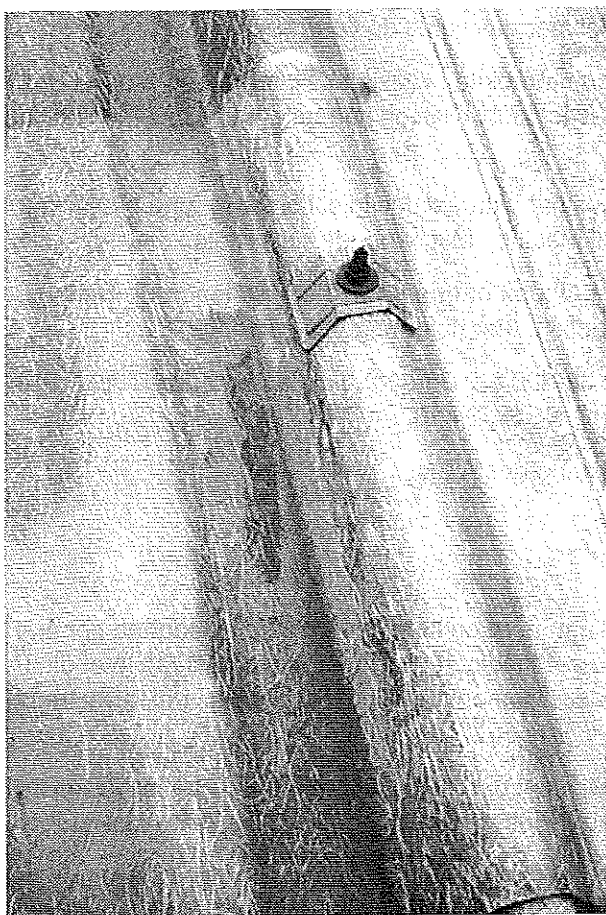
Photo 1 : Plaque translucide PRV. Simple paroi. Effet du défilage de l'armature et des salissures. © J. Putatti
