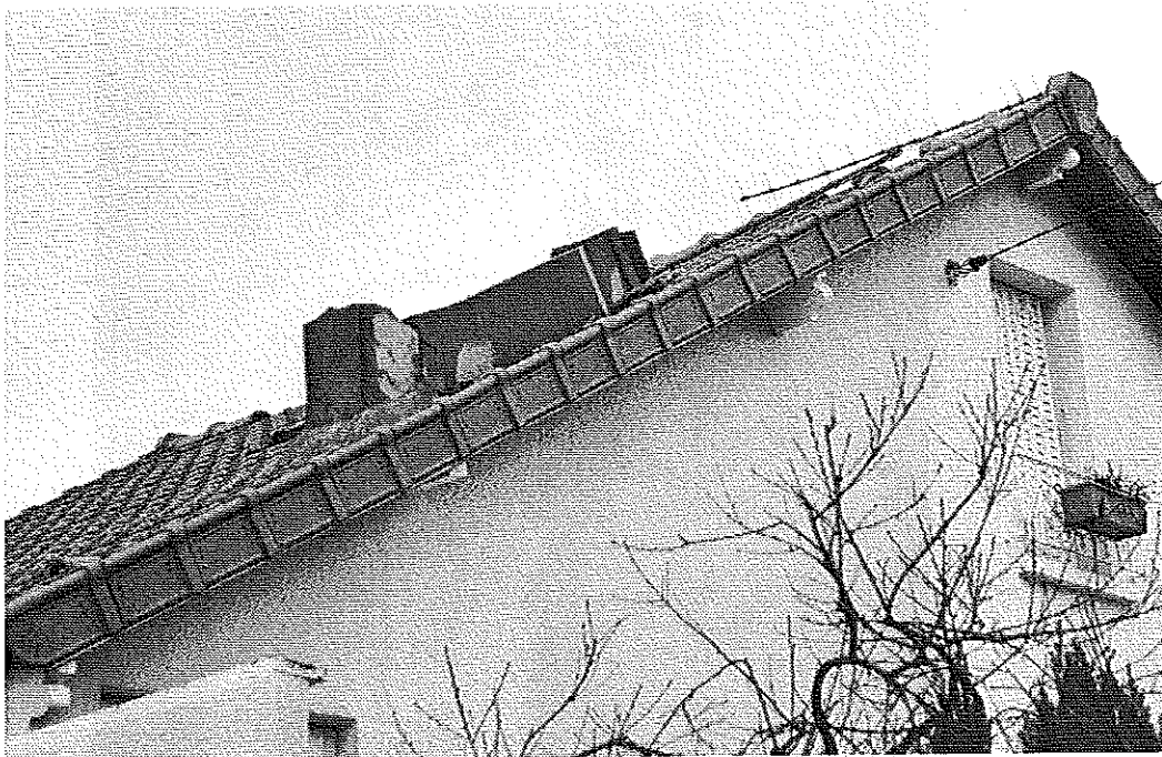
Photo 4 : Vue versant exposition ouest. Souche couchée sur le versant avec antenne. © J. Putatti
